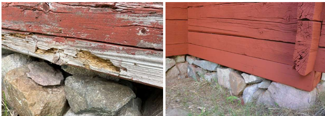
Fig. 4 och 5. Före och efter åtgärder.
