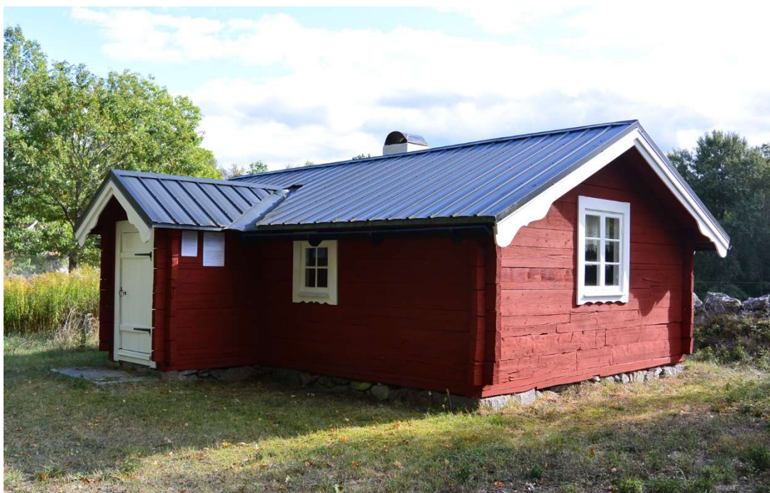
Fig. 14. Lottens stuga, vy mot sydost, efter arbetet, jfr fig. 1.
