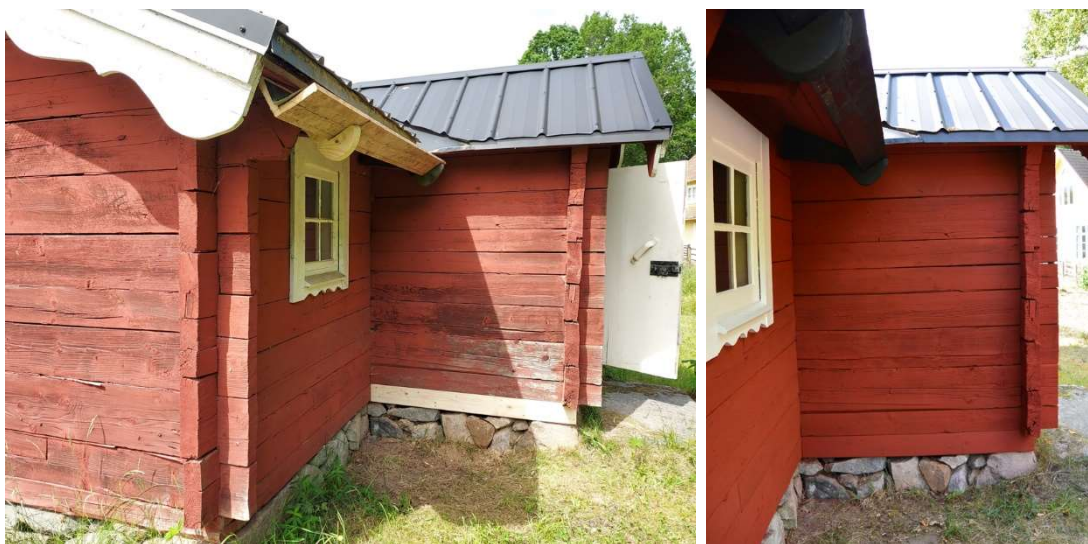
Fig. 6. Nyttillverkad hängränna och rännkrok är på plats och fasadens nedre del samt syll är lagade. Fig. 7. Motsvarande parti efter arbetet.
