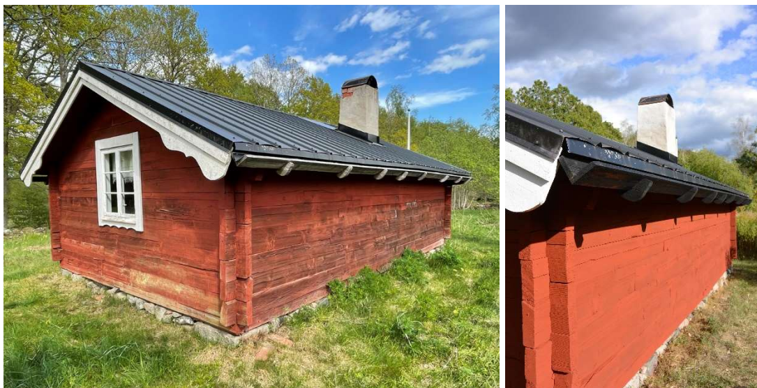
Fig. 12 och 13. Vy mot nordost, före och efter arbetet.
