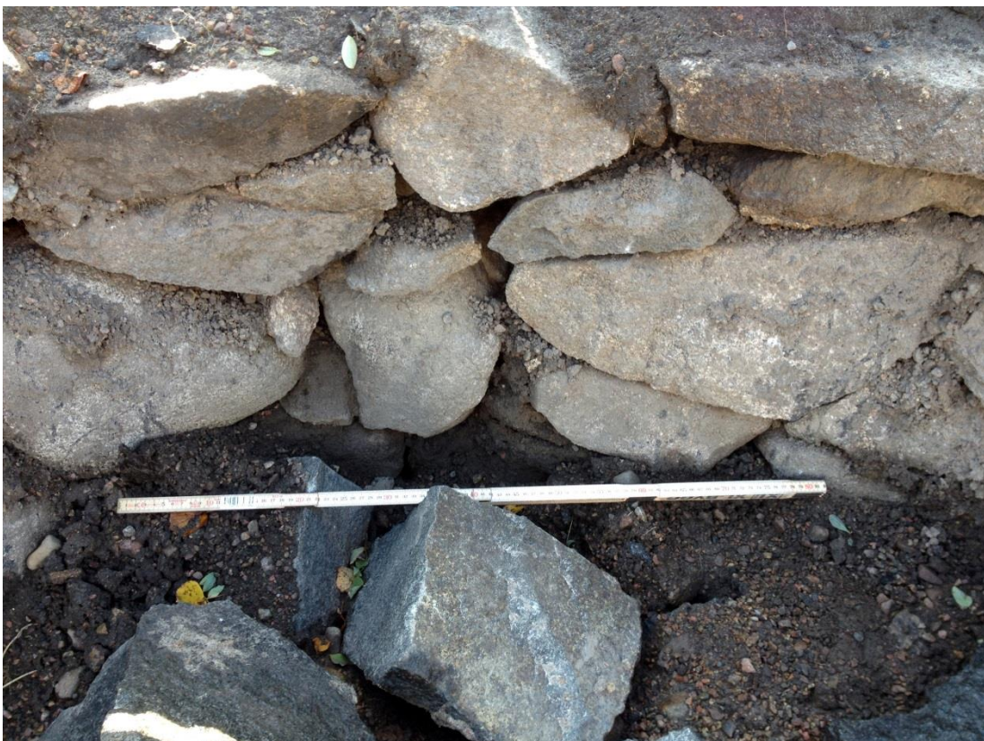
Figur 6 Vällagd kallmur i natursten och tuktad sten
