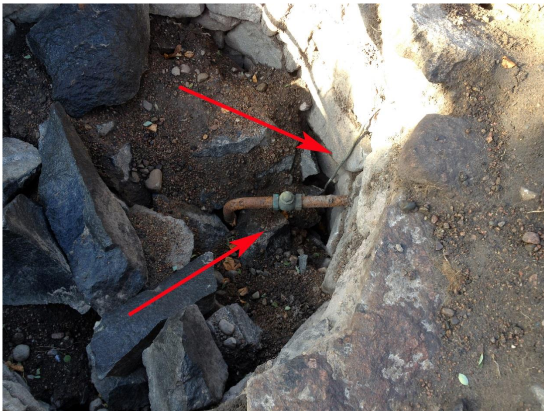
Figur 7 Vid övre röd pil kopparkabel/äskledare, nedre röd pil rördragning
