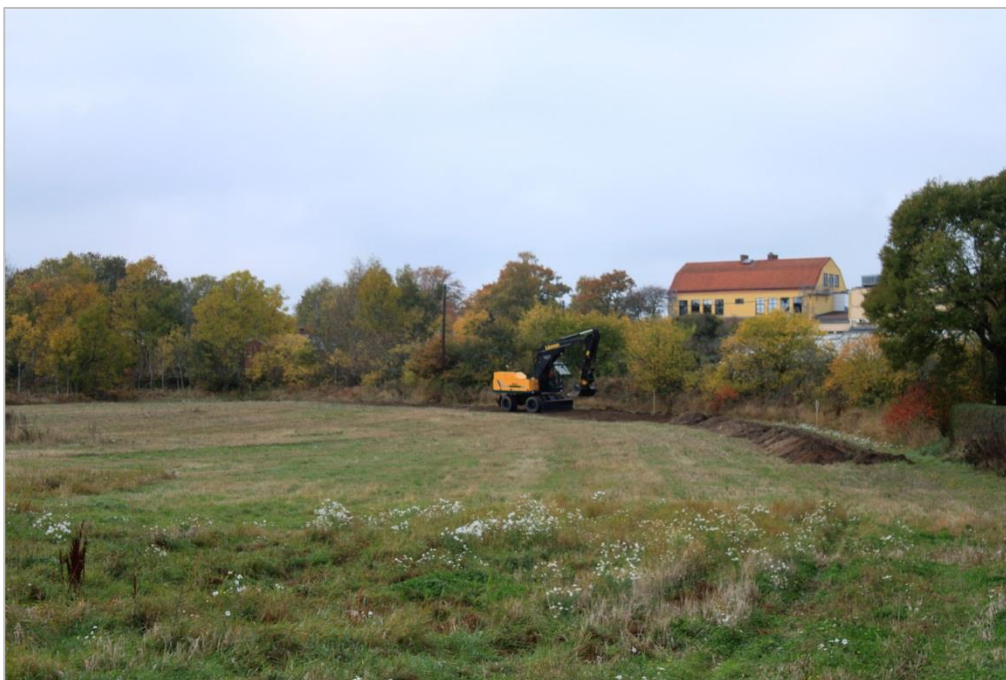
Figur 3 Delsträcka 1 översikt mot SV Schakt 1
