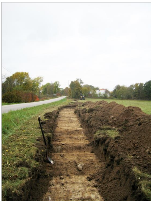
Figur 2 Delsträcka 1 Schakt 7 mot NV
