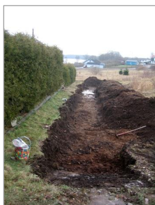
Figur 7 Delsträcka 2 Schakt 40 mot SÖ
