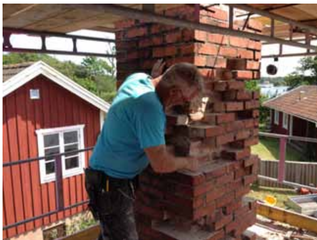
Reparation av den stora skorstenen till bastrumman.
