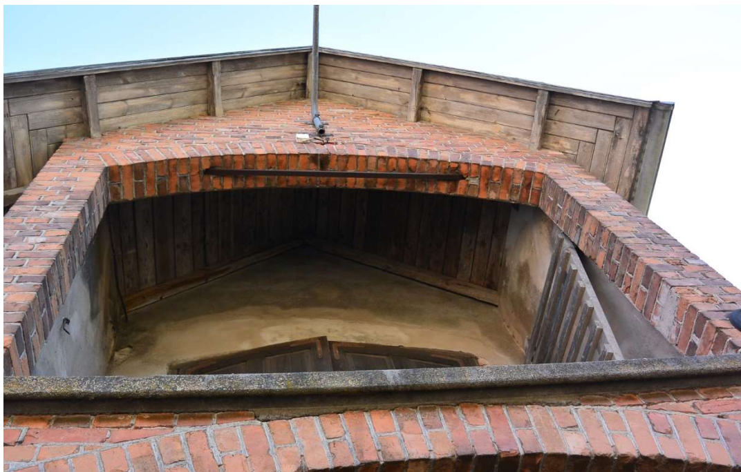
Fig. 4. Övre delen av västra entrén efter arbetet.
