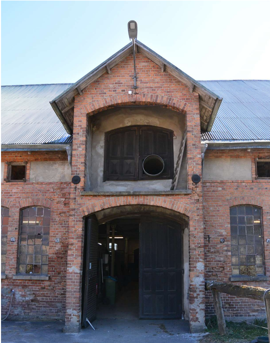
Fig. 5. Den västra huvudentrén efter arbetet.
