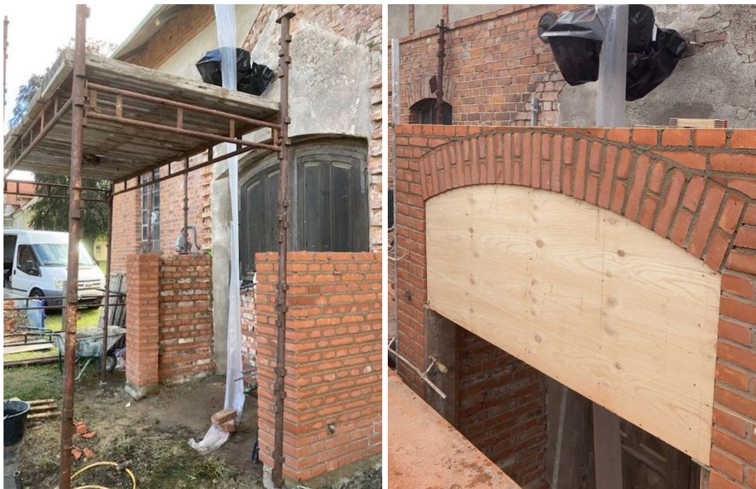
Fig. 9. Återuppbyggnad av väggarna. Fig. 10. Tegelvalvet är slaget ovanpå stommen.
