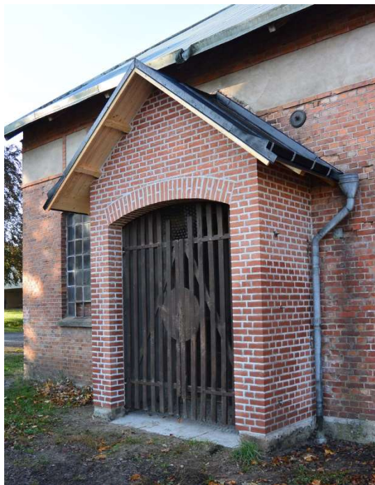
Fig. 11. Entrén är återuppbyggd. Det nya taket är täckt med råspont och underlagspapp, plättäckning återstår.
