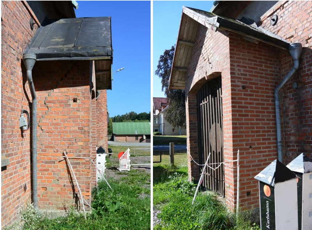
Fig. 5. Den sydöstra entrén, vy mot norr, före arbetet. Fig. 6. Den sydöstra entrén, vy mot söder, före arbetet. Tegelväggen närmast i bild är inte original utan uppbyggd i samband med renovering, troligtvis i senare tid. I bakgrunden skimtar Jannebergs mangårdsbyggnad.
