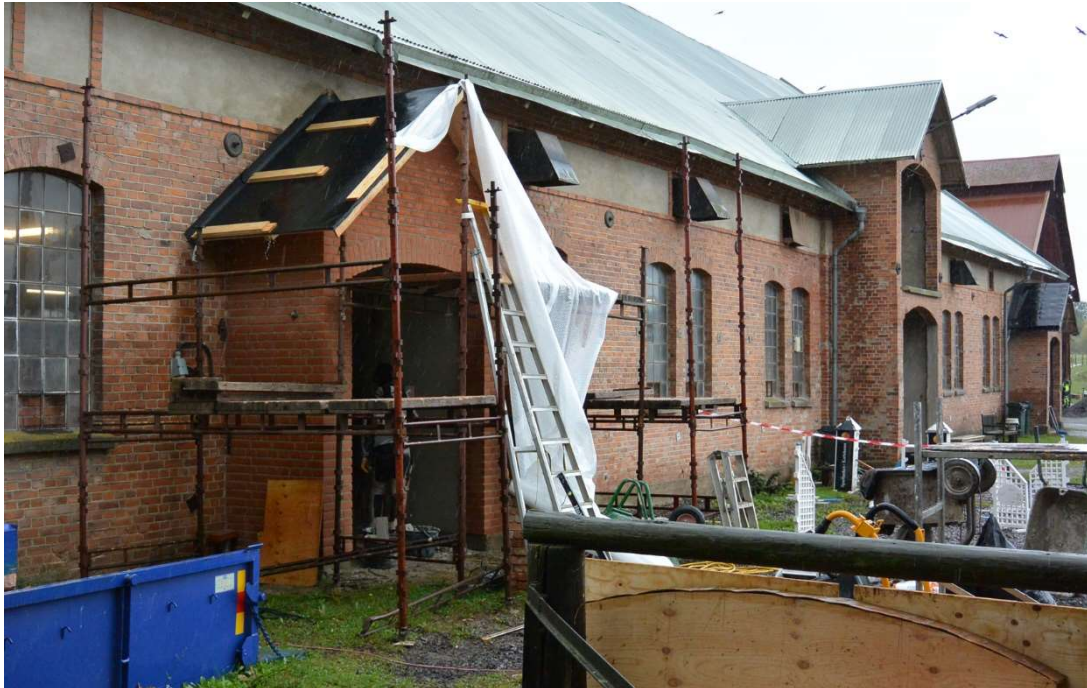
Fig. 11. Entrén är återuppbyggd. Det nya taket är täckt med råspont och underlagspapp, plättäckning återstår.
