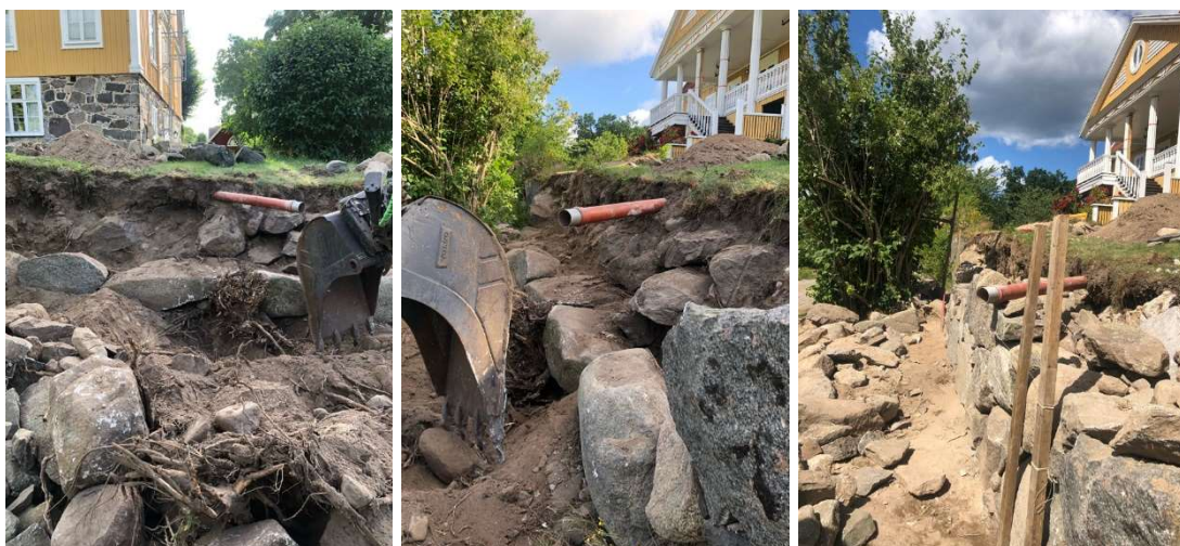
Fig. 12. Mursträcka 2 under renovering. Muren är demonterad och hasselbusken och dess rotsystem har grävts bort. Fig. 13. Grundstenarna är blottlagda, vy mot norr. Fig. 14. Muren under återuppbyggnad, vy mot norr.
