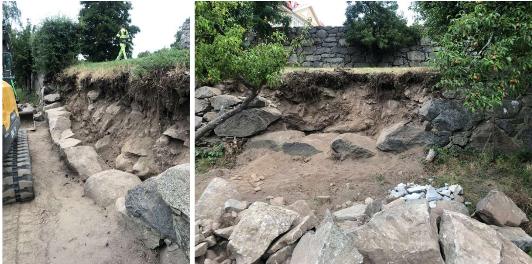
Fig. 17. Den västra delen av mursträckan under arbetet. Fig. 18. Den östra delen av mursträckan är demonterad, jfr fig. 21.
