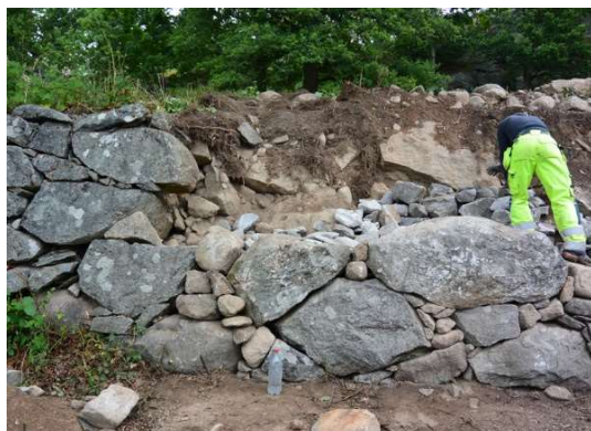
Fig. 4. Vy mot norr, före renovering, jfr fig. 8. Fig. 5. Muren har demonterats och är under återuppbyggnad. Notera de stora stenblocken i bakkant.
