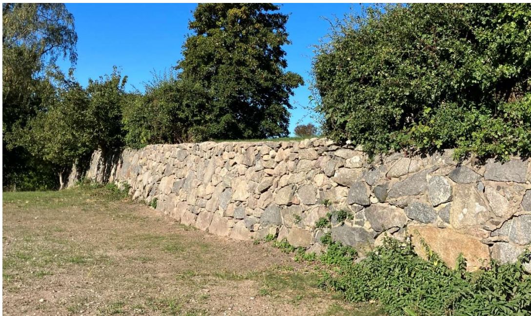
Fig. 19. Den västra mursträckan efter renovering.
