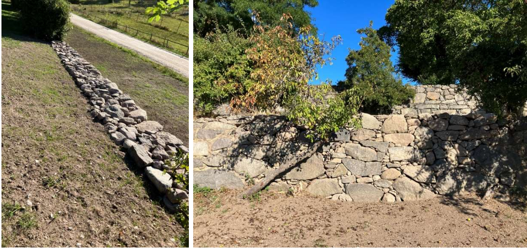
Fig. 20. Ovansidan av den västra mursträckan med återskapat krön. Fig. 21. Den östra mursträckan efter renovering, jfr fig. 18.
