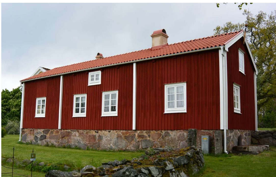
Fig. 15. Södra fasaden efter arbete. En viss ojämnhet kan märkas mellan gammalt och nytt virke men det kommer att jämnas ut med tiden.
