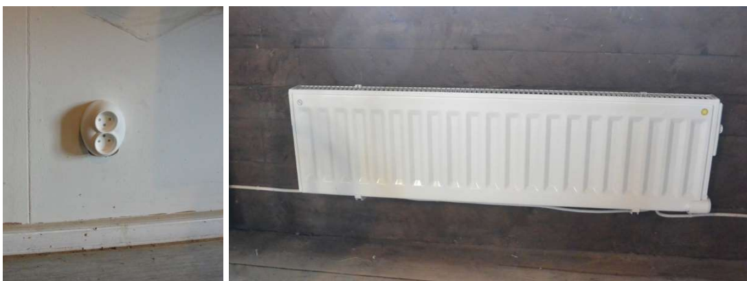
Fig. 18. Nytt eluttag på övre våningen. Fig. 19. Ny radiator i ett av rummen på nedre plan.
