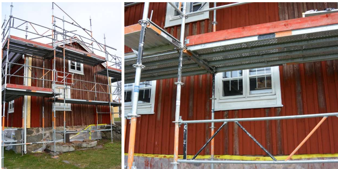
Fig. 13. Östra gaveln, under arbete. Fig. 14. Partiellt byte av panel och locklist på södra fasaden.
