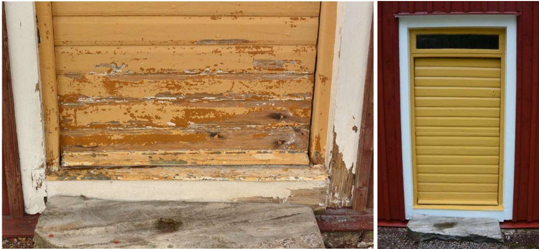
Fig. 16. Den östra dörren längs norra fasaden, under arbete. Fig. 17. Östra dörren efter arbete.
