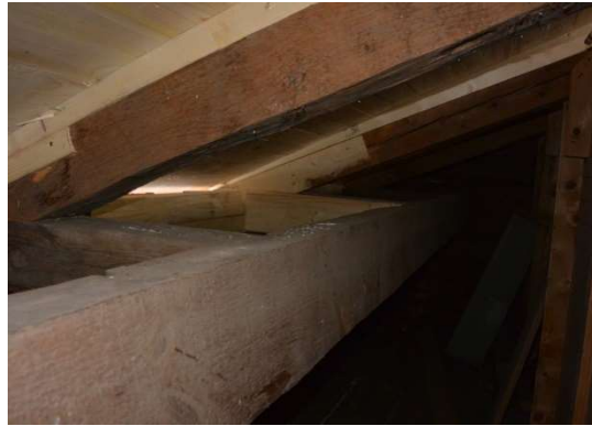
Fig. 7. Insidan av södra takfallet med rötskadade delar. Fig. 8. Förstärkta sparrar och ny råspond utmed norra takfallet.
