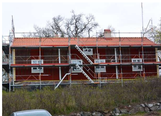
Fig. 11. Södra takfallet. Pannorna är utlagda i väntan påläggning. Fig. 12. Efter läggning med nya takpannor.
