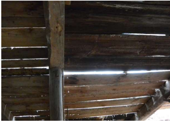
Fig. 7. Insidan av södra takfallet med rötskadade delar. Fig. 8. Förstärkta sparrar och ny råspond utmed norra takfallet.
