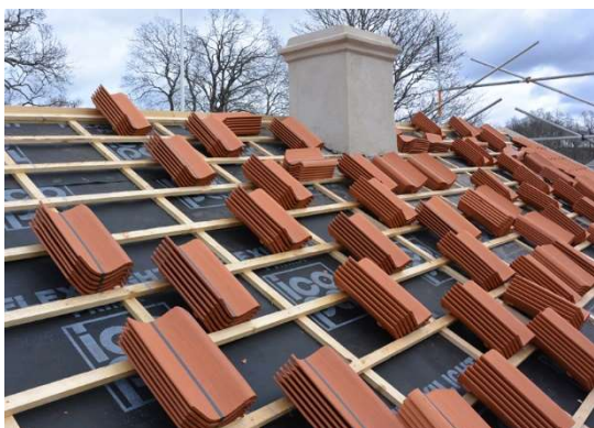
Fig. 11. Södra takfallet. Pannorna är utlagda i väntan påläggning. Fig. 12. Efter läggning med nya takpannor.
