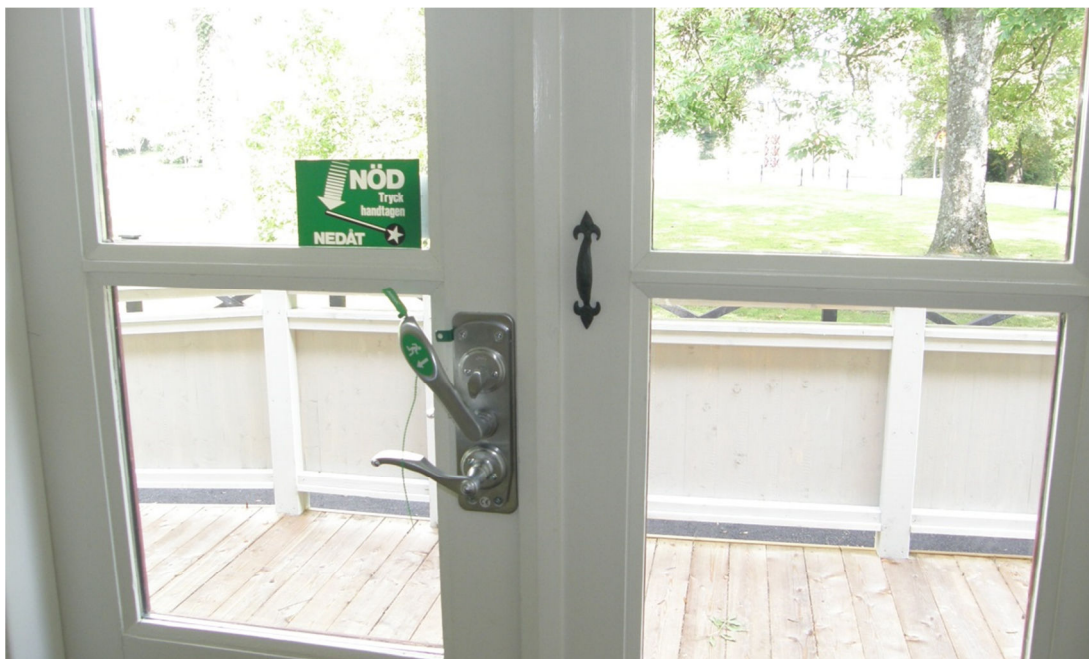
Fig. 14. Norra entrén med nytt utrymningsbeslag och svartmålat draghandtag.
