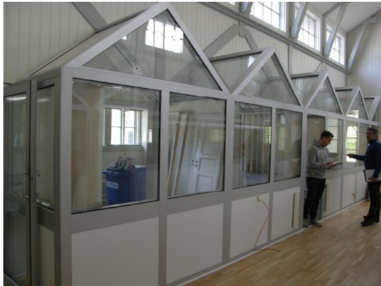
Fig. 9. Norra delen, V sidan, före arbetet.
