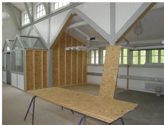
Fig. 6. Ny vägg under uppförande.
