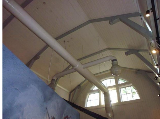
Fig. 12. S delen, ventilationsdon efter arbetet.
