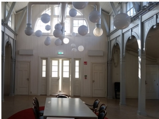
Fig. 11. S delen, ventilationsdon före arbetet.
