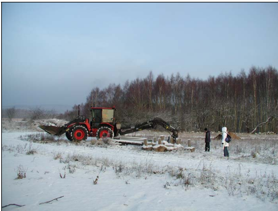
Fig.2 – Schaktning för provgropar inom undersökningsområdet. Fotografi mot N.
