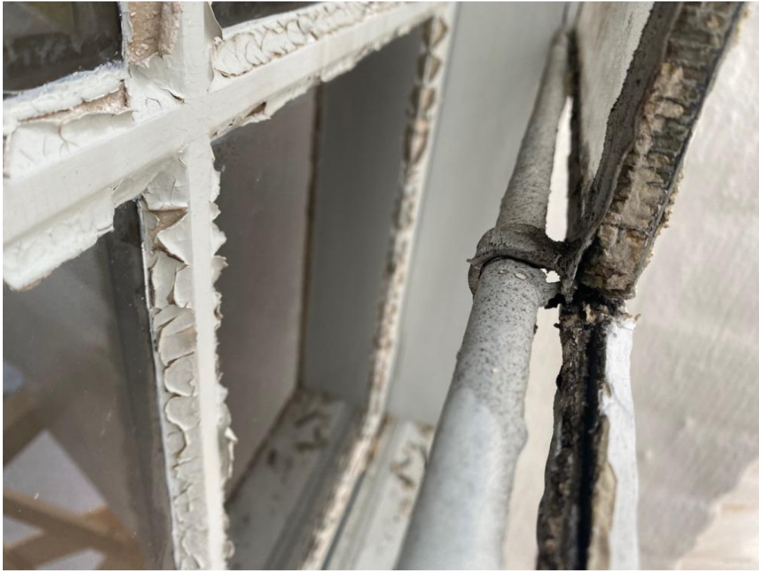
Fig. 4. Befintlig infästning med blyplåt mot stormjärn, innan arbetet. Foto Thor Lindqvist.
