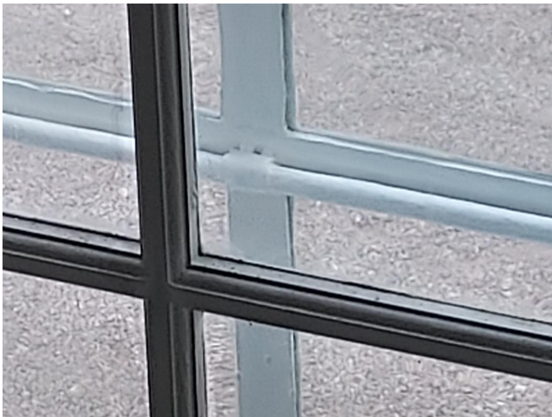
Fig. 6. Detalj på ny infästning mot stormjörn. Jämför med fig. 8.
