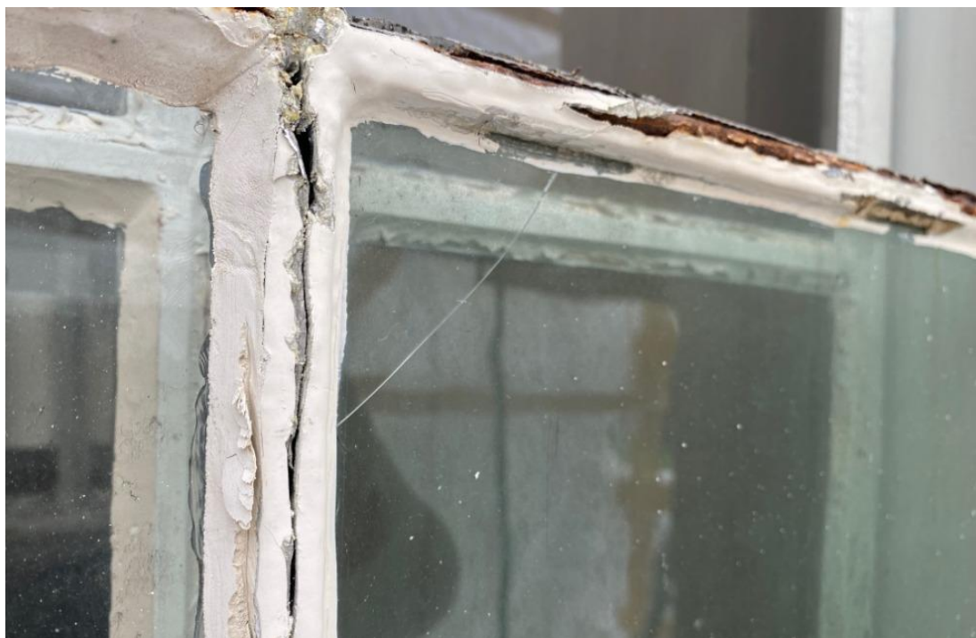
Fig. 1. Skadad blyspröjs. Foto Thor Lindqvist.
