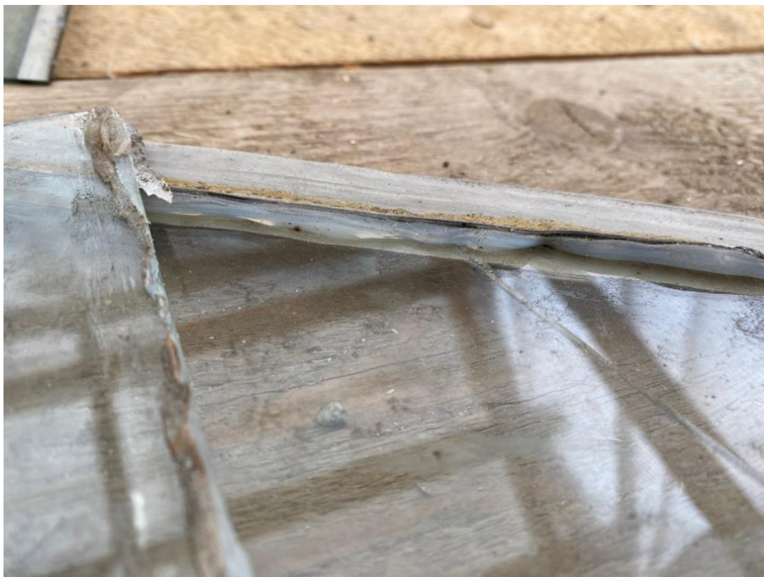
Fig. 2 . Glas fäst med silikon. Foto Thor Lindqvist.
