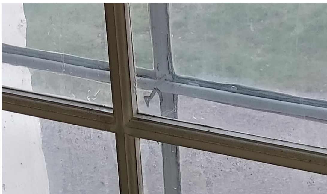
Fig. 8. Infästning med najad koppartråd mot stormjärn, innan arbetet.
