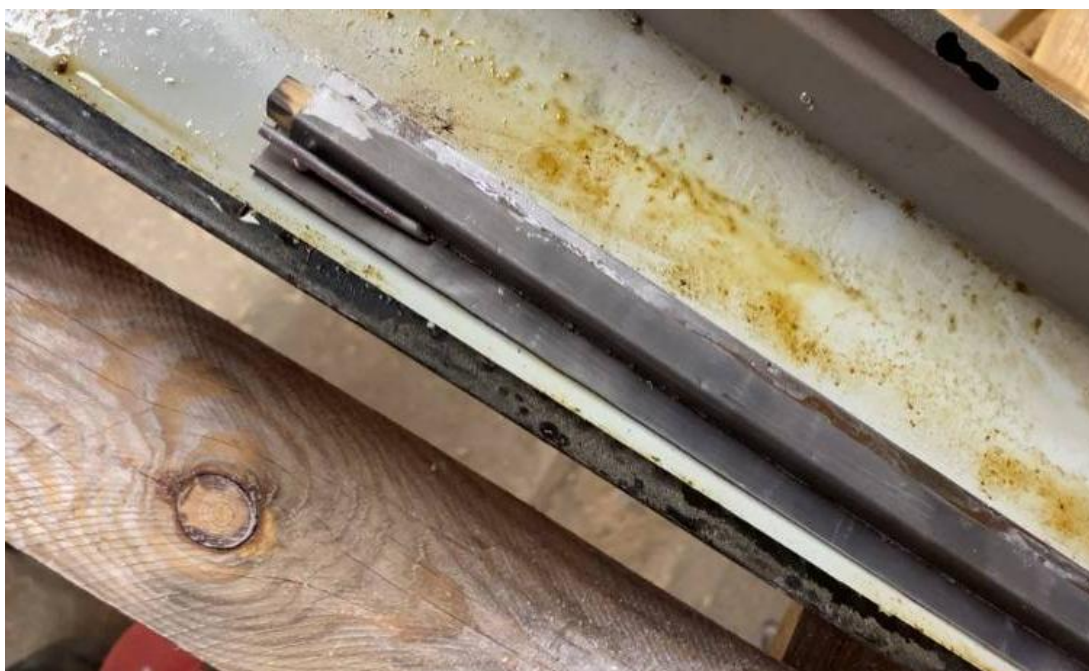
Fig. 3. Tillverkning av ny spröjs med ekkärna. Foto Thor Lindqvist.
