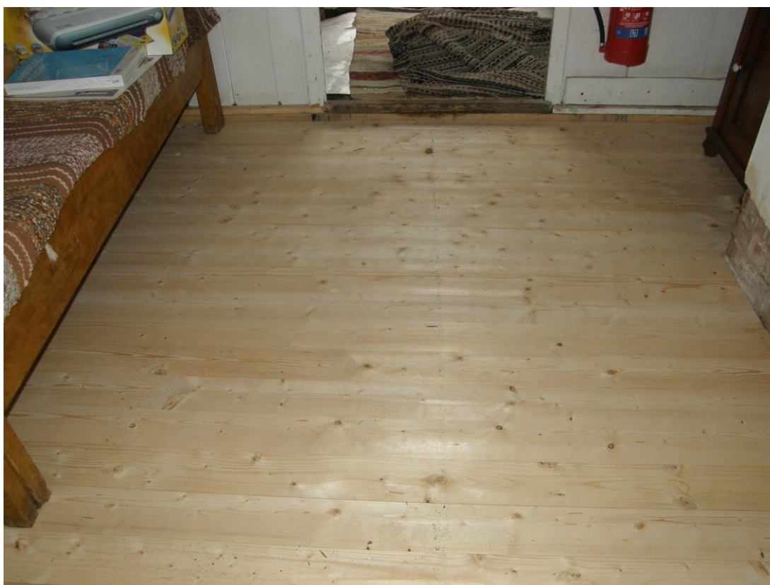
Fig. 4. Nytt golv av maskinhyvlad gran.
