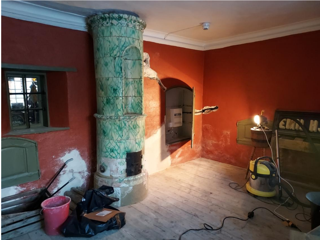
Fig. 14. Upphuggen vägg i handelsbodens kontor (källaren).
