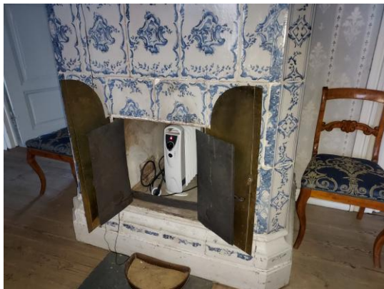
Fig. 10. Äldre elradiator i kakelugn.
