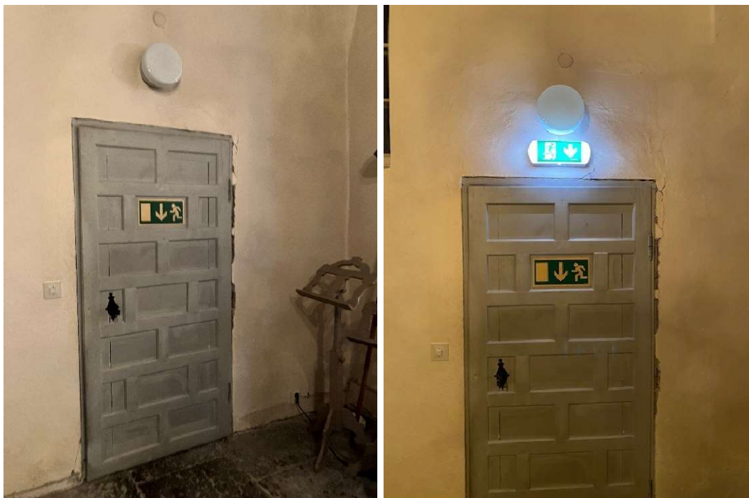
Fig. 2. Kordörren före arbetet. Fig. 3. Kordörren efter arbetet (foto: Henrik Persson).
