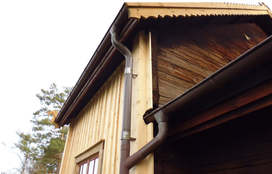
Fig. 3. Vy mot södra knutlådan.
