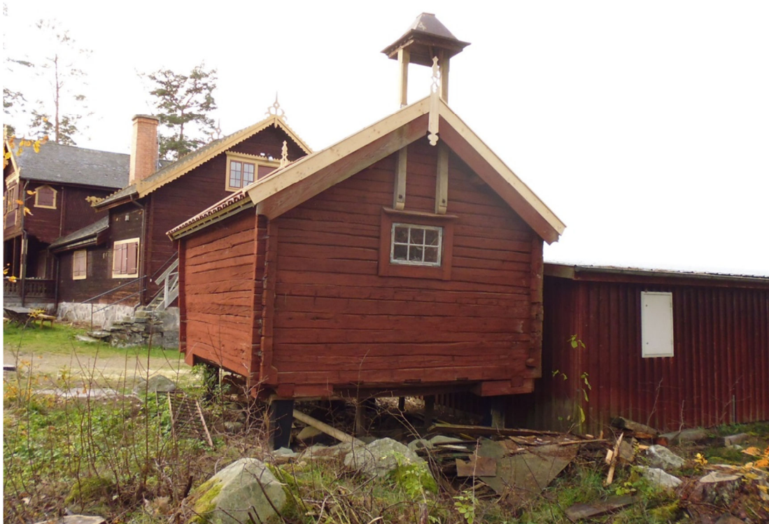
Fig. 11. Visthusboden, norra gaveln. Notera nya stolpar på klockbocken.
