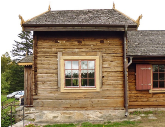
Fig. 1. Västra fasaden före arbetet.
