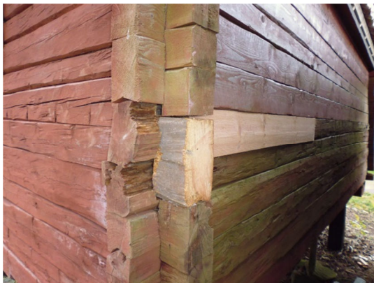
Fig. 10. Västra fasaden lagad.
