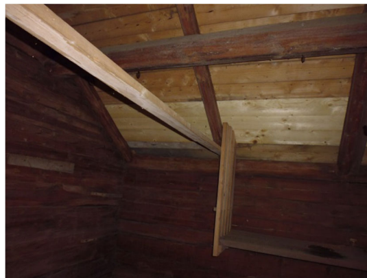
Fig. 8. Utbytt underbrädning.
