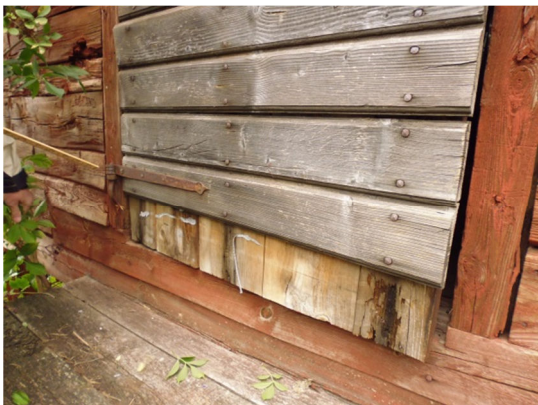
Fig. 9. Saknad panelbräda på dörren.
