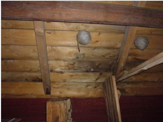
Fig. 7. Rötskadad underbrädning.
