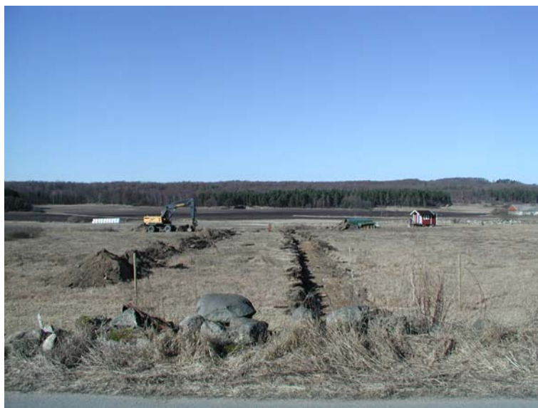
Fig. 2 Längre sökschakt mot väster.
