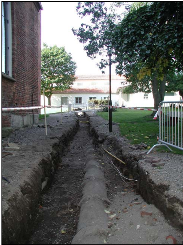
Fig. 5 Framrensad kulvert N om kyrkan, fotograferad mot V.
