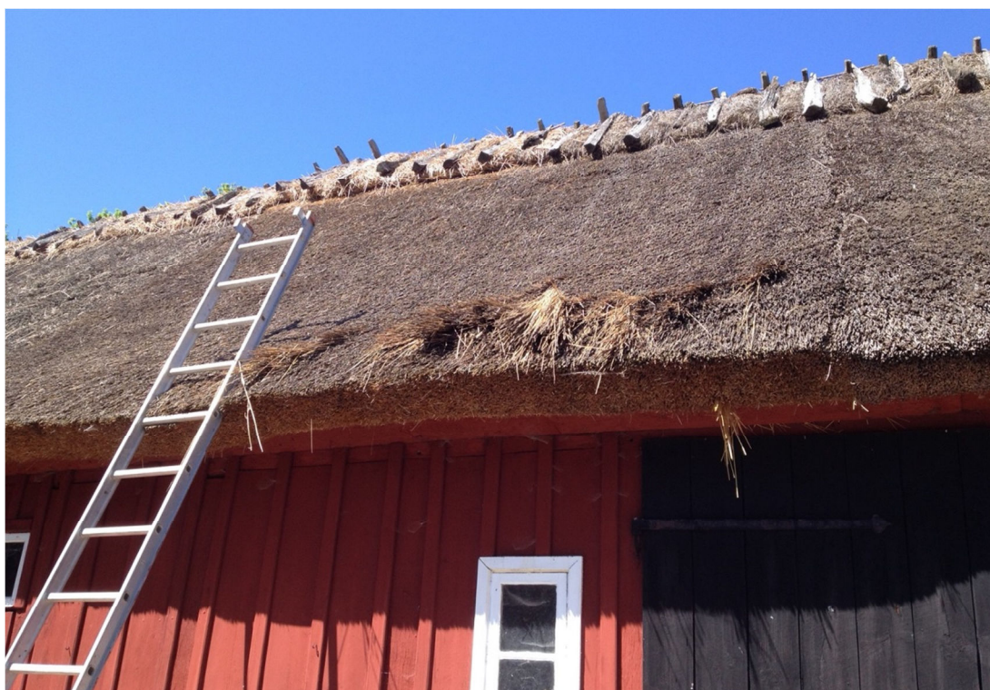
Fig. 6. Exempel på skada efter råttangrepp. Skadan lagad på fig. 5. Foto Ingmar Melin.
