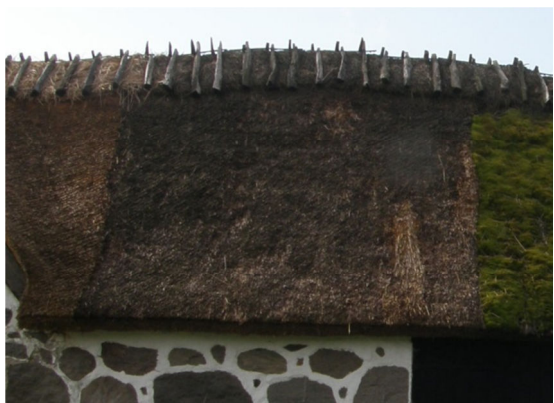
Fig. 4. Exempel på lagningar, norra takfallet.
