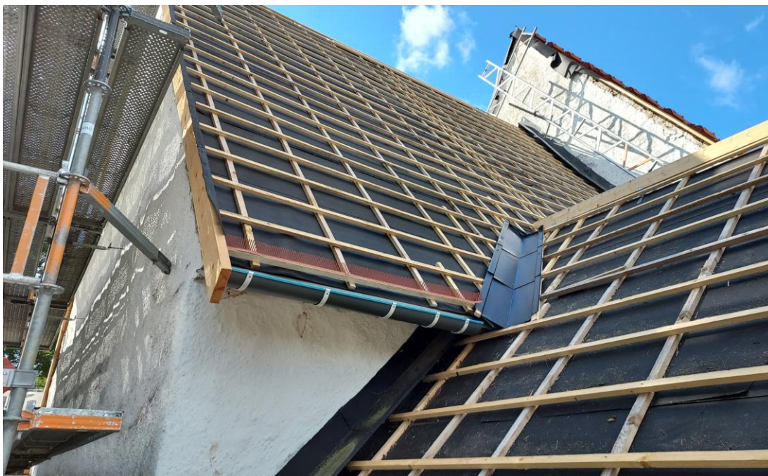
Fig. 2. Omläggning av korets och sakristians takfall.
