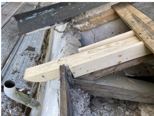
Fig. 23 (t.v.). Bytt takfotstass på sakristian, fastspikad på taksparren. Fig. 24 (t.h.). Gammal och ny taksparren. Foto Evelina Lindeberg.
