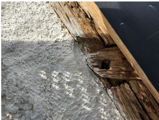
Fig. 15. Kvarsittande del av hanband.
