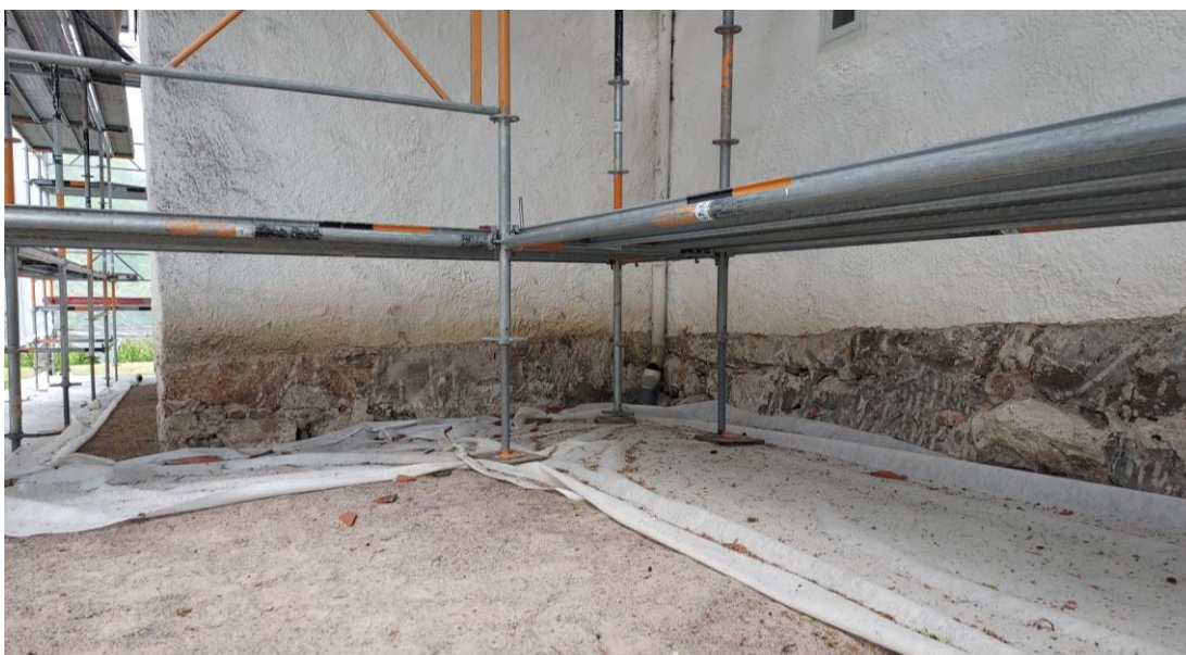
Fig. 8. Nedre delen av befintlig puts borttagen. Vapenhusets västra fasad till höger.
