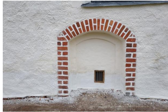
Fig. 10. Nordportalen, efter arbetet.
