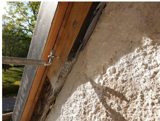
Fig. 16. Skarvning av södra sparren.
