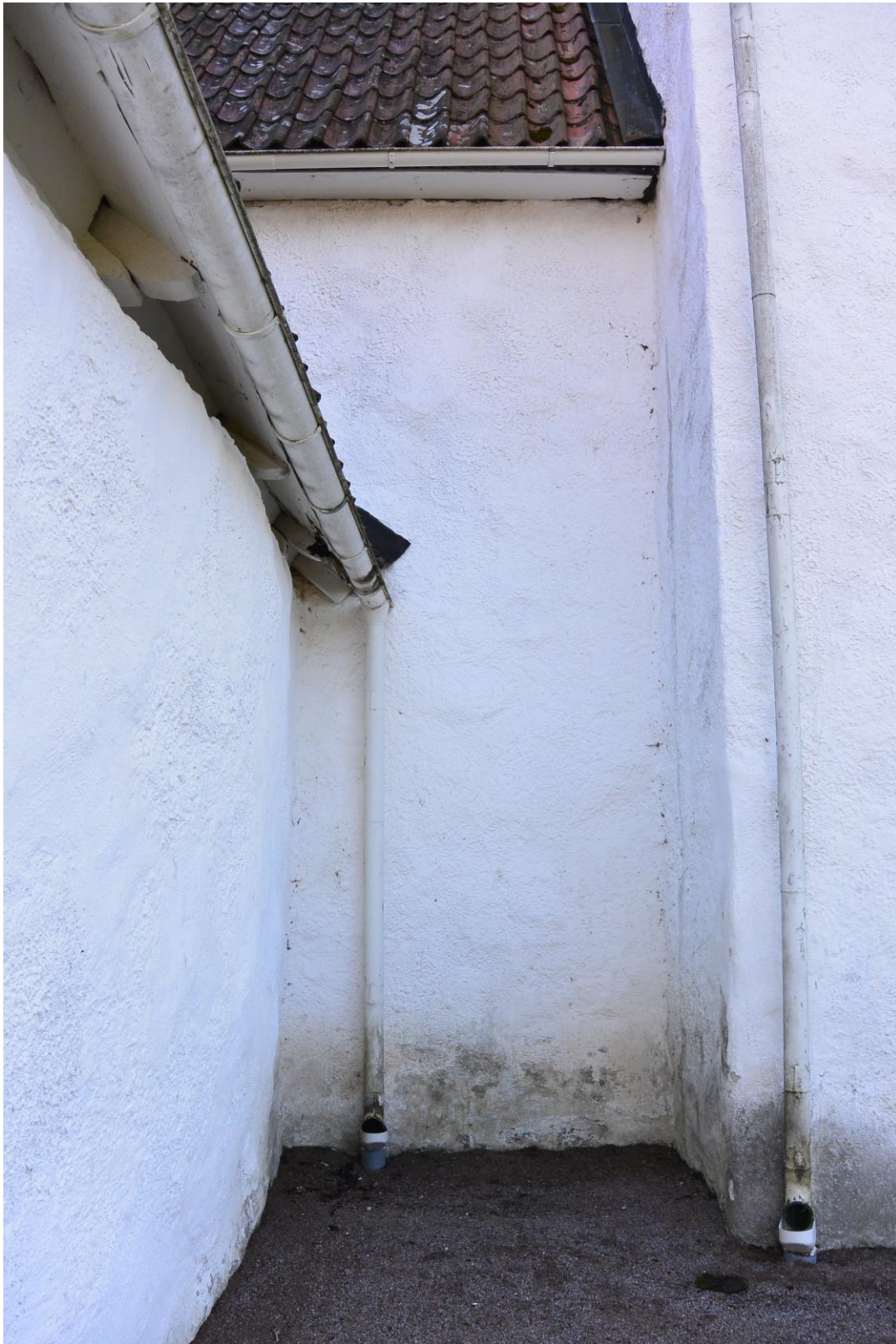
Fig. 20. Gattet mellan sakristian och långhuset. Innan arbetet. Foto Cissela Olsson.
