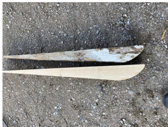
Fig. 23 (t.v.). Bytt takfotstass på sakristian, fastspikad på taksparren. Fig. 24 (t.h.). Gammal och ny taksparren. Foto Evelina Lindeberg.
