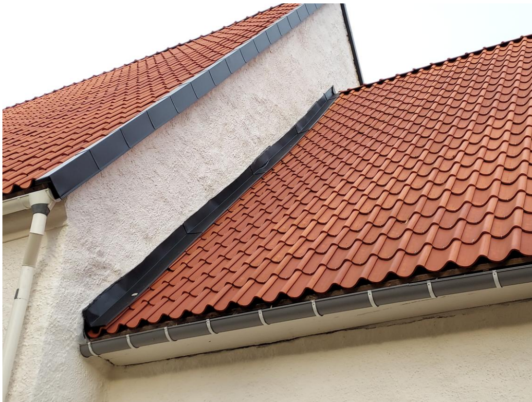
Fig. 3. Nytt tegeltak på långhuset och koret. Ståndskivan återanvändes medan vindskivorna nyttillverkades.
