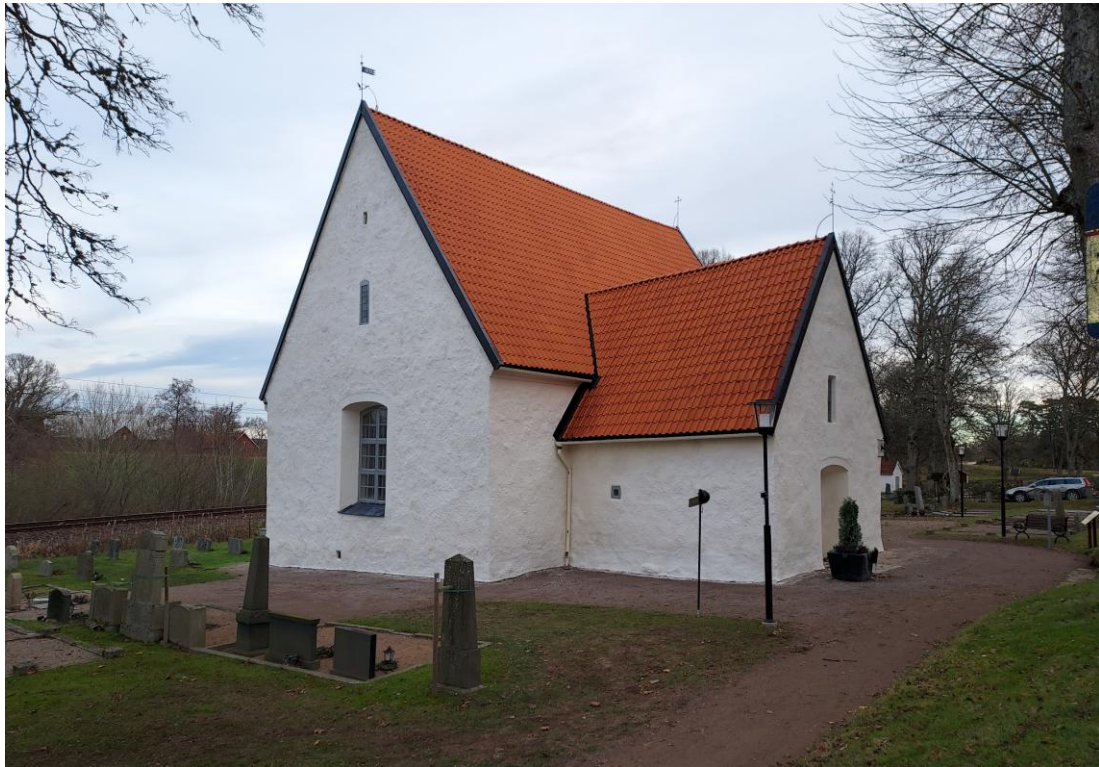
Fig. 25. Kyrkan efter arbetet. Vy mot nordöst.
