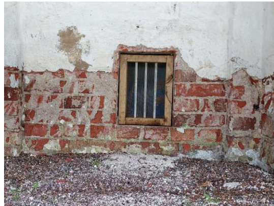
Fig. 12. Nytt, stort ventilgaller.
