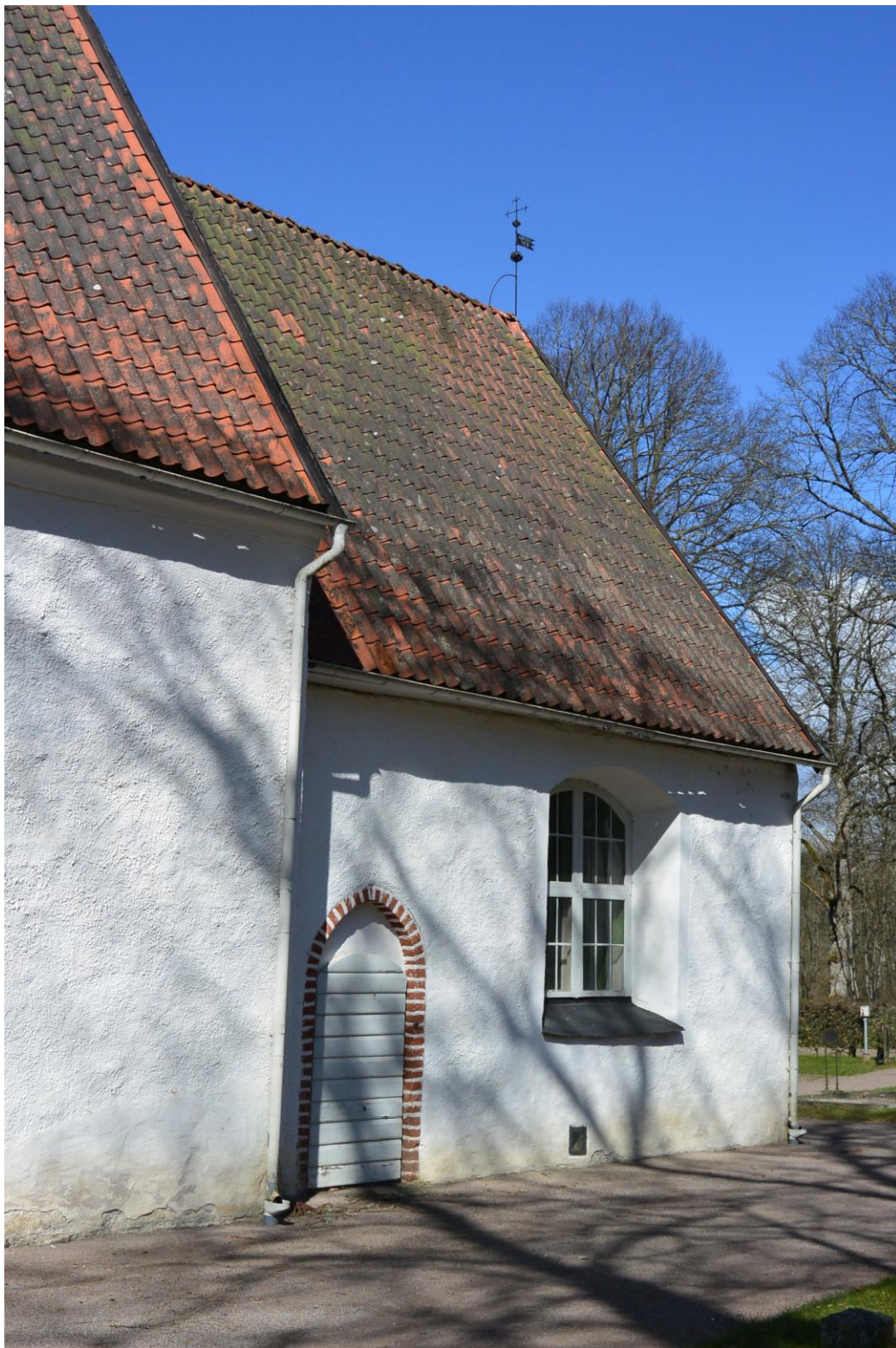
Fig. 21. Vy mot korets södra fasad. Innan arbetet. Foto Cissela Olsson.
