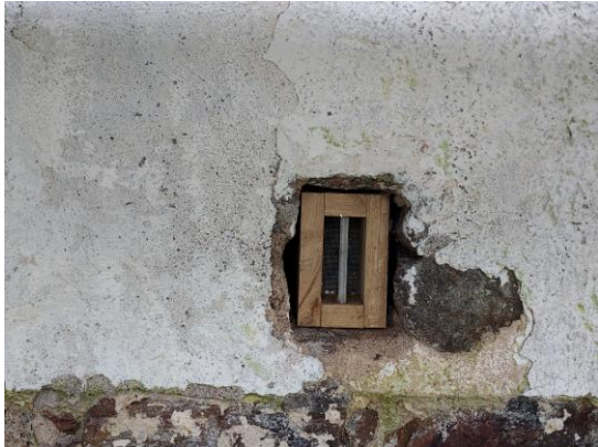
Fig. 11. Nytt, litet ventilgaller.
