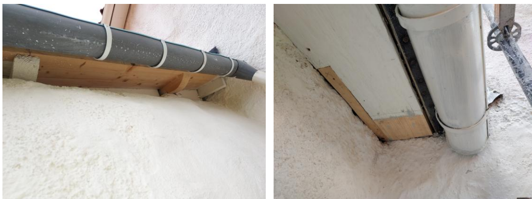
Fig. 4 (t.v.). Sakristian, bytt underbrädning och ny takfotstass, se gröna markeringar på fig. 1. Fig. 5 (t.h.) Lagad underbrädning, se den övre röda punkten på fig. 1.
