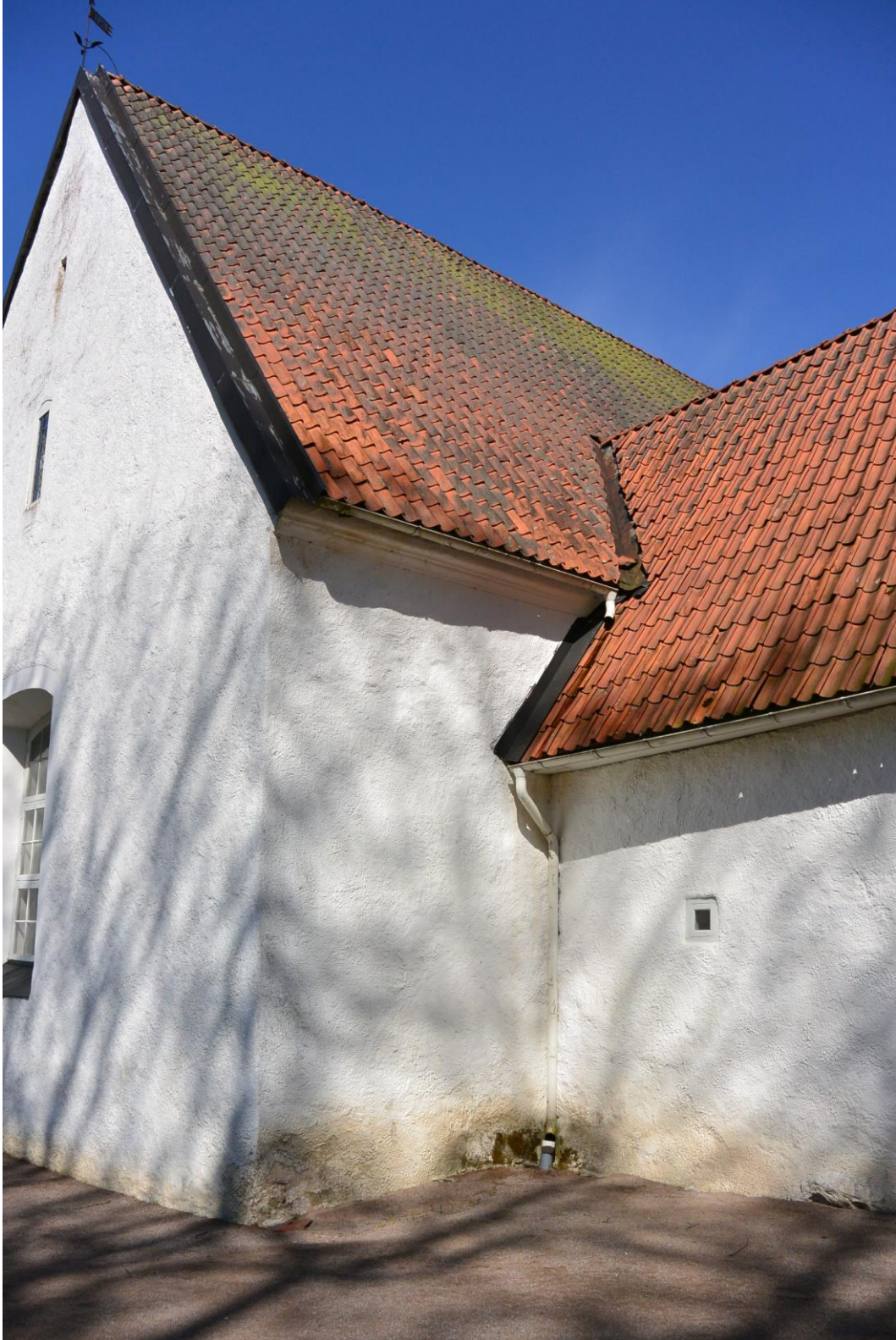
Fig. 19. Västra innerhörnet mellan långhuset och koret, innan arbetet. Foto Cissela Olsson.
