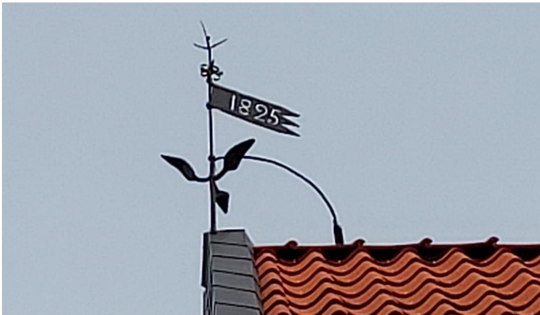
Fig. 13. Vindflöjel, renoverad och återmonterad.
