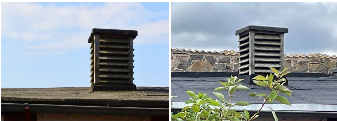
Fig. 14 och 15. Uthusets ventilationshuv före och efter arbetet.
