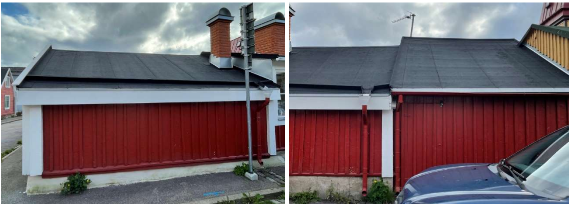
Fig. 12 och 13. Västra takfallet efter arbete. Jämför fig. 4 och 5.
