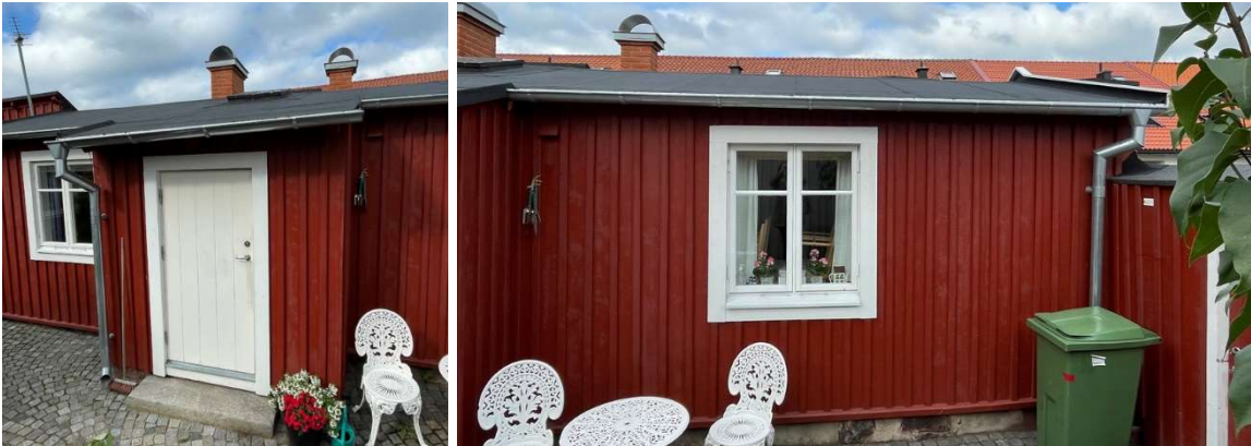
Fig. 10 och 11. Östra takfallet efter arbete. Jämför fig. 2 och 3.
