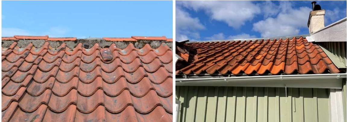
Fig. 16 och 17. Bostadshusets östra takfall, före och efter arbetet.
