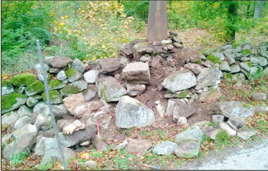
Bild 15 RAÄ Jämjö 37:1 fundament under åtgärd. Foto mot NV
