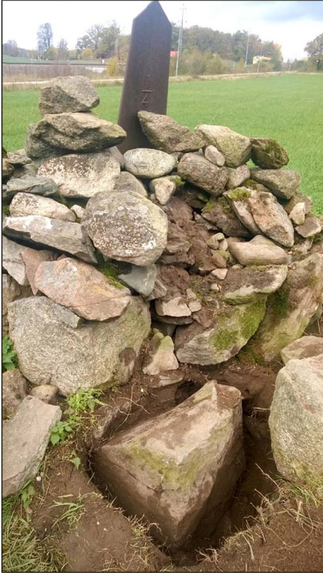
Bild 30 RAÄ Rödeby 23:1 åtgärd pågår. Foto mot V
