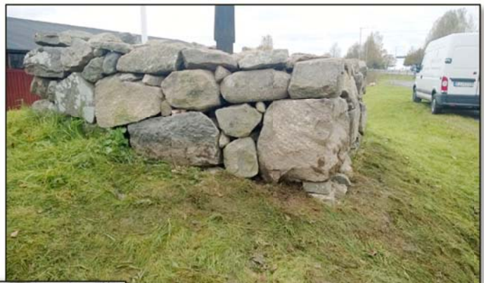
Bild 12 RAÄ Asarum 37:1 sättning på fundament, efter åtgärd. Foto mot N
