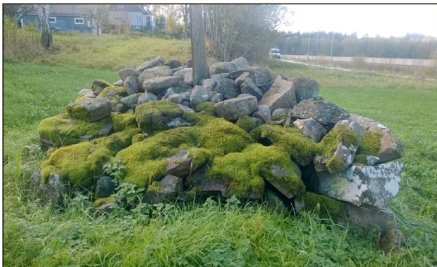
Bild 27 RAÄ Rödeby 23:1 milstolpe och fundament före åtgärd. Foto mot S
