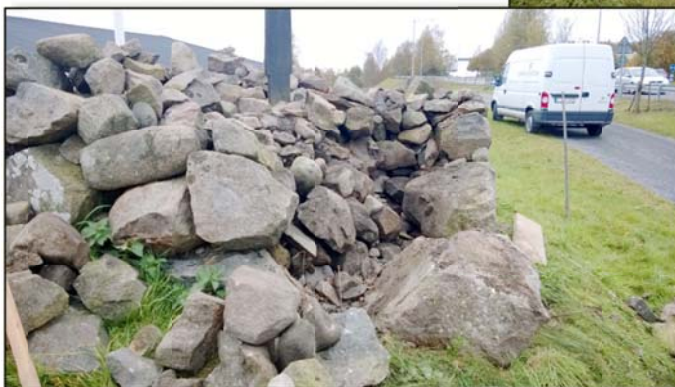
Bild 11 RAÄ Asarum 37:1 sättning på fundament, under åtgärd.
