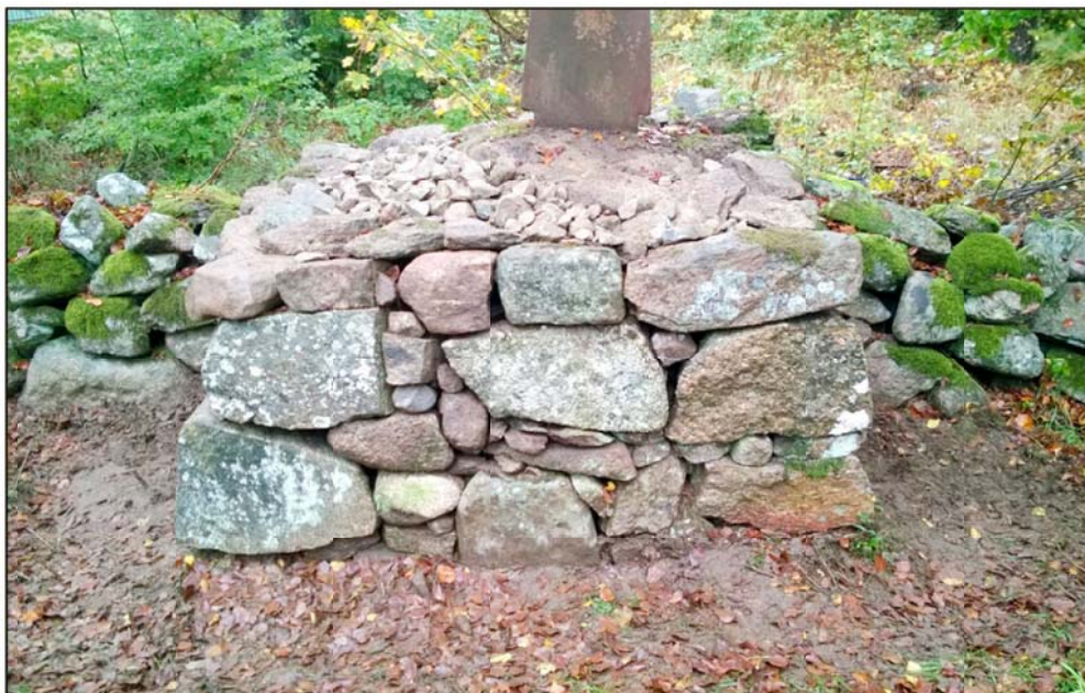
Bild 14 RAÄ Jämjö 37:1 efter åtgärd. Foto mot V
