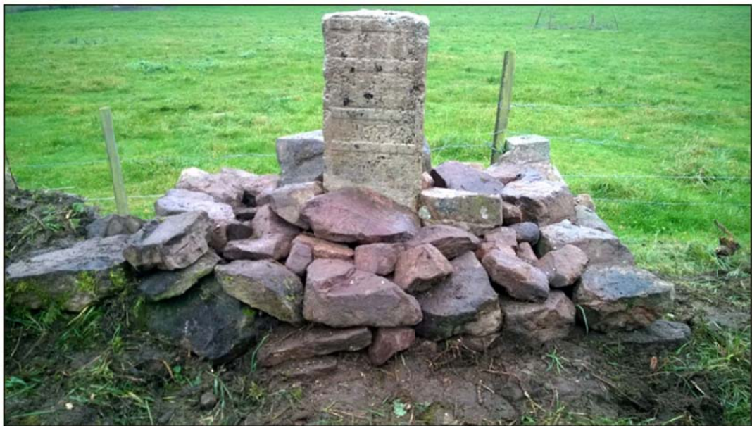
Bild 2 RAÄ Asarum 1:1 efter åtgärd. Foto mot S
