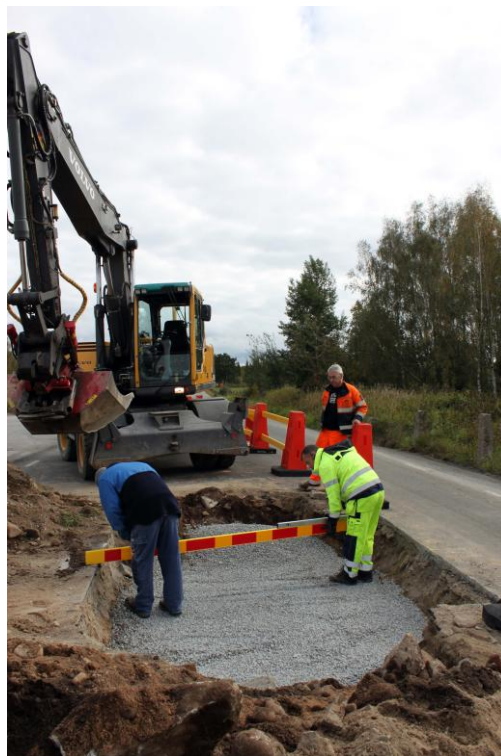
Uppmätning av påfört material
