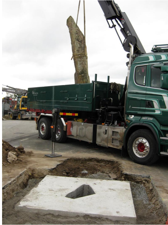
Stenen placeras i sitt fundament
