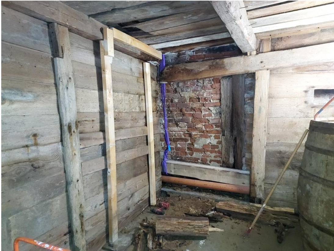
Fig. 5. Under arbetet med att byta stolpen. Vänstra bindbjälken stämpad.
