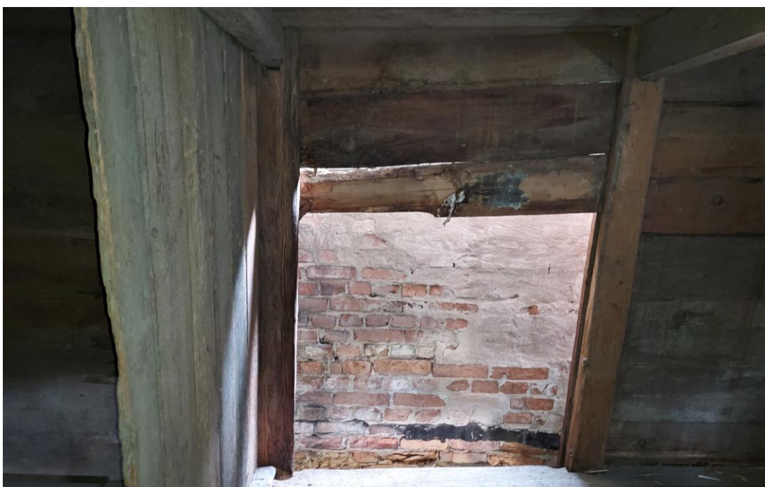
Fig. 4. Övervåningen. De tre övre, rötskadade bälorna sitter fortfarande kvar mellan stolparna.
