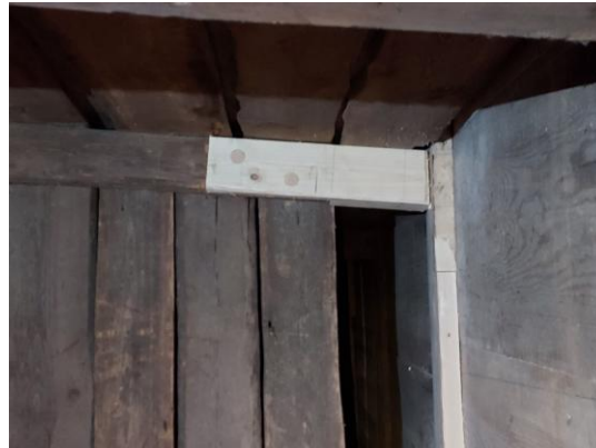
Fig. 10. Dubbning av stående bladskarv.
