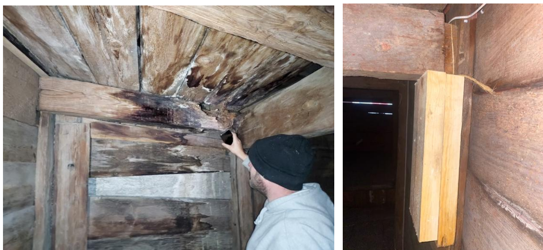
Fig. 12 (t.v.). Svår rötskada i stallets västra del. Fig. 13 (t.h.). Urkragad tapp på södra sidan, temporärt fixerad med påskruvad konsol – att spika var uteslutet. Foto Thor Lindqvist.
