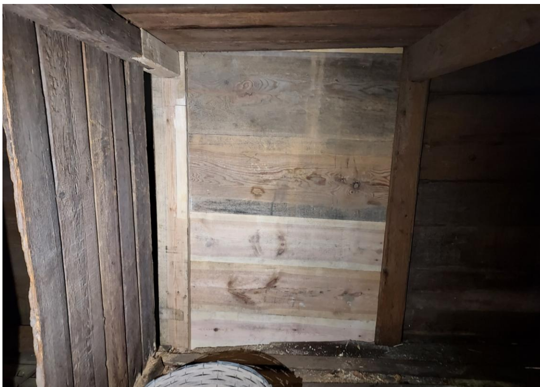
Fig. 8. Övervåningen, efter arbetet.
