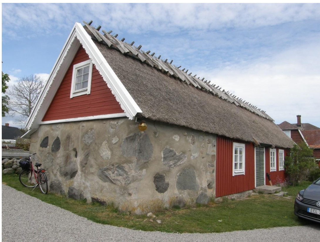
Fig. 1. Jullas hus, innan arbetet. Vy mot öster.
