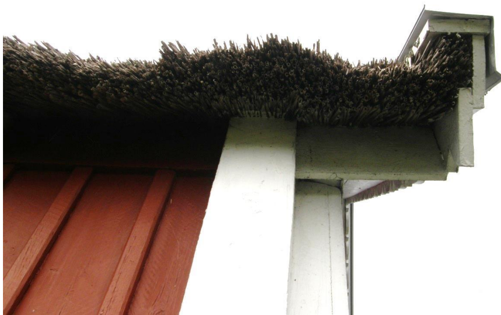
Fig. 4. Starkt nedslitet takfall.
