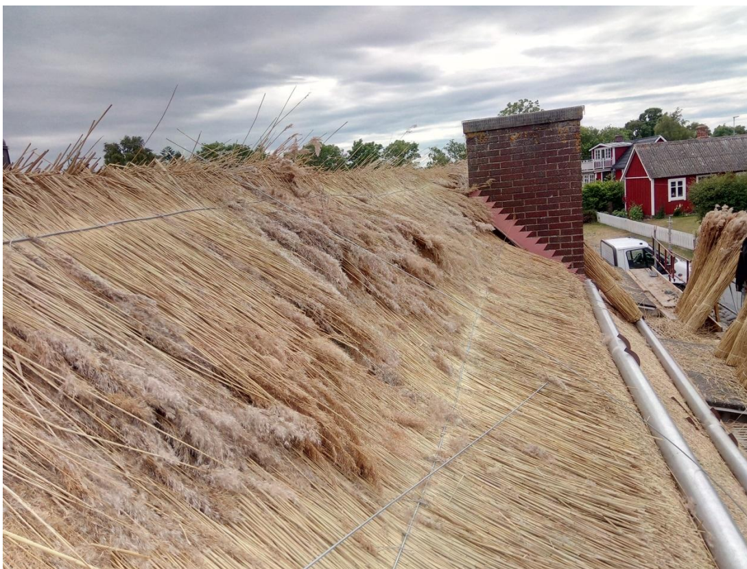
Fig. 13. Vy övernocken, innan ryggnig. Notera rafterna av 0,5 cm rundjärn.
