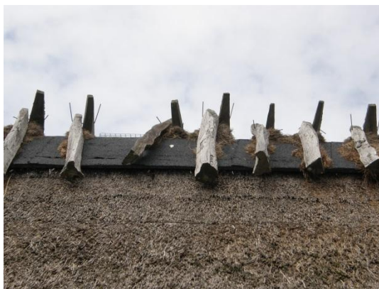
Fig. 3. Takpappsklätt nockskydd av brädor.
