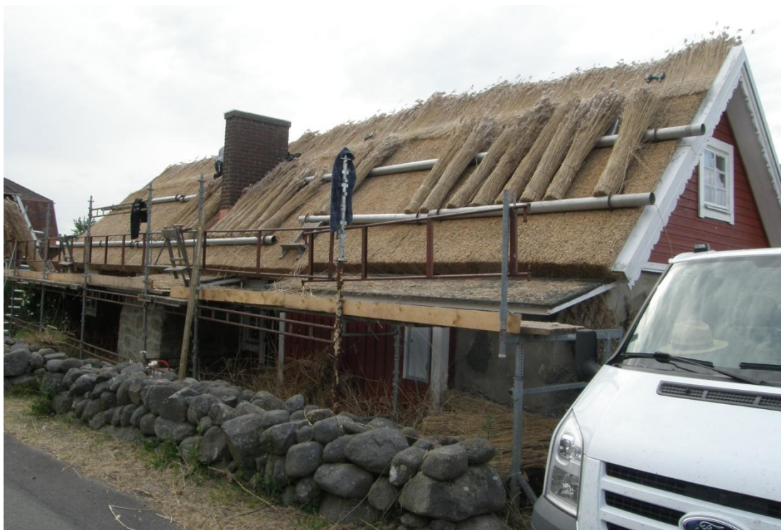
Fig. 5. Arbetsbild, norra takfallet.
