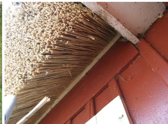
Fig. 7. Stödläkt under takskägget.
