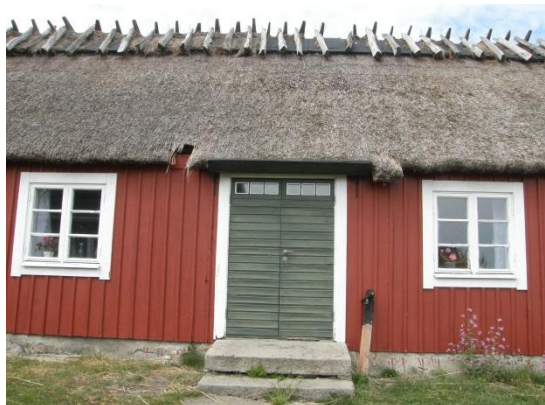
Fig. 2. Nedkasat takskägg vid entrén.
