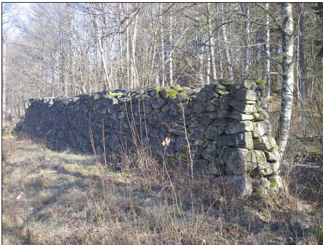
Bilaga 5b - Stenmur, kvarstående efter det rivna kvarnstallet. Fotografi mot N.
