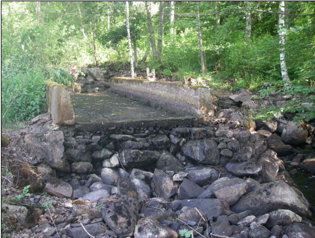
Bilaga 5c - Gjuten ränna N om kvarnbyggnaden efter vårlöden. Fotografi mot NNV.
