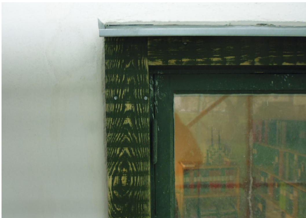
Fig. 14. Exempel på nya fönsterfoder efter omslipning, men innan slutmålning.
