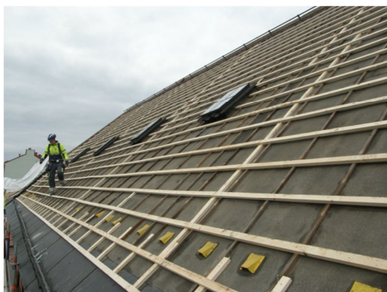
Fig. 9. Södra takfallet under arbetet.
