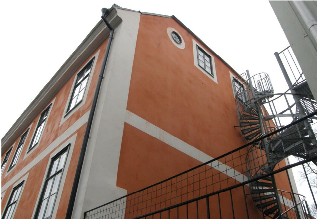
Fig. 7. Östra gaveln efter arbetet. De bägge mitre gavelfönstren är utbytta, varav det högra utgör nödutgång.
