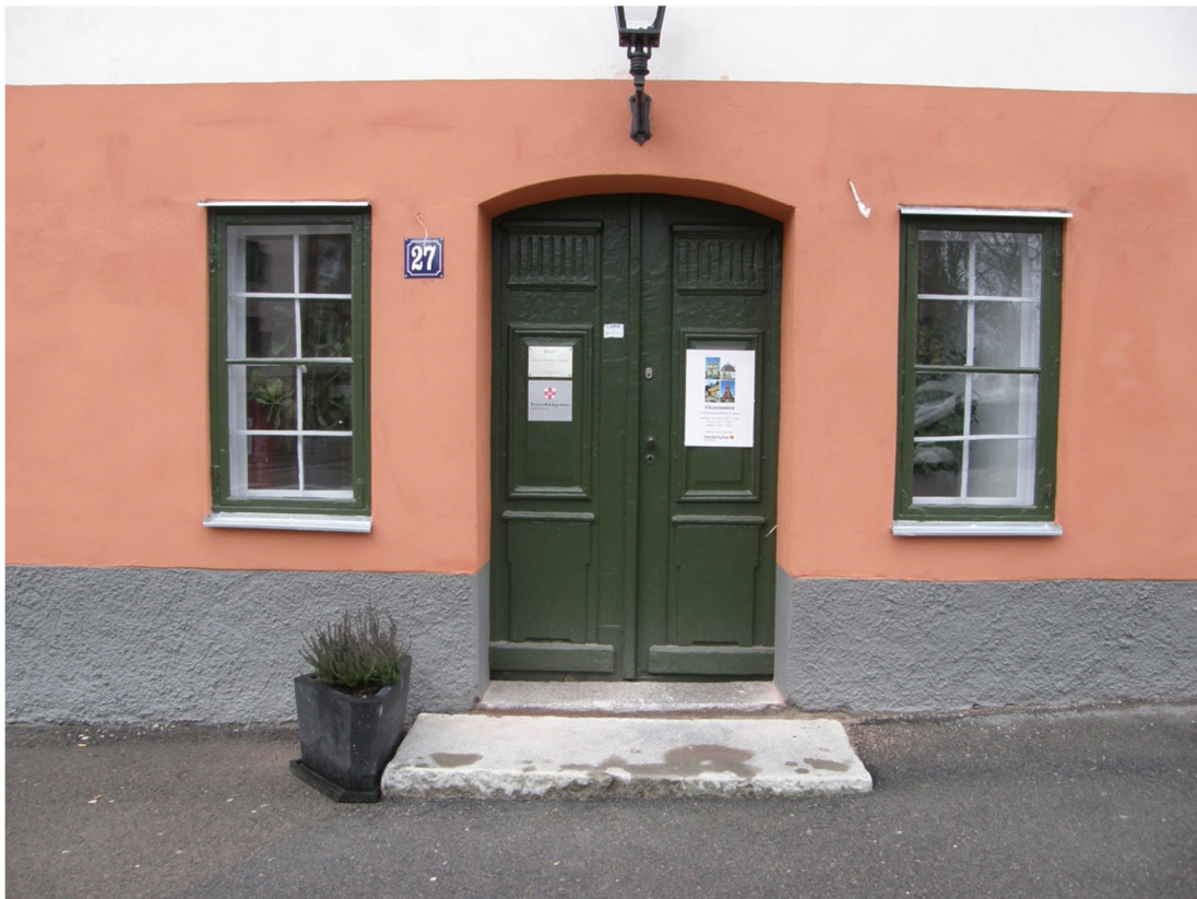
Fig. 13. Entrédörren på södra långsidan ommålad. Jämför med fig. 2.
