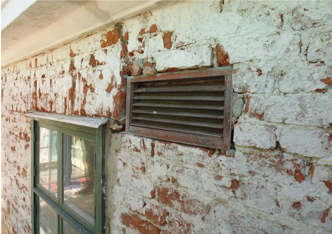
Fig. 5. Lamellventil som togs bort under arbetet. Södra långsidan, vid övre östra fönstret.
