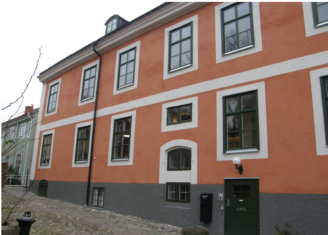
Fig. 8. Norra långsidan efter arbetet.
