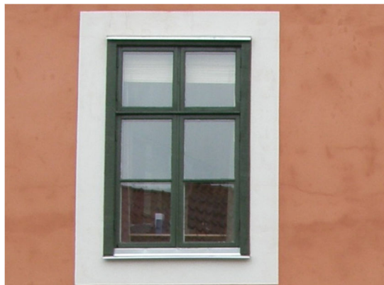
Fig. 16. Nytt fönster efter ombyggnaden.
