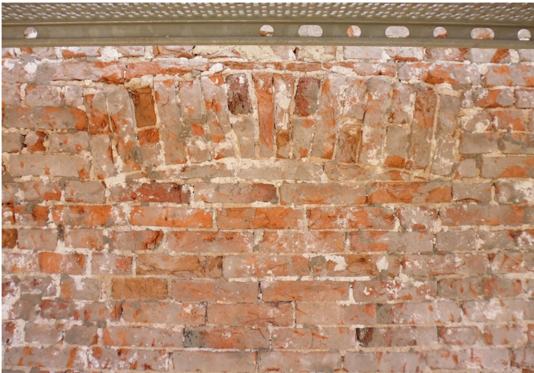
Fig. 6. Platsen för en igenmurad intagslucka (bakom det övre blindfönstret på västra gaveln).
