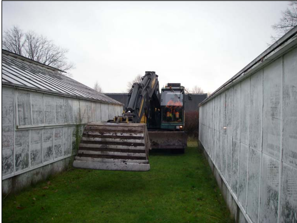
Fig.3 - Dragning av Schakt 23 mellan drivhus.
