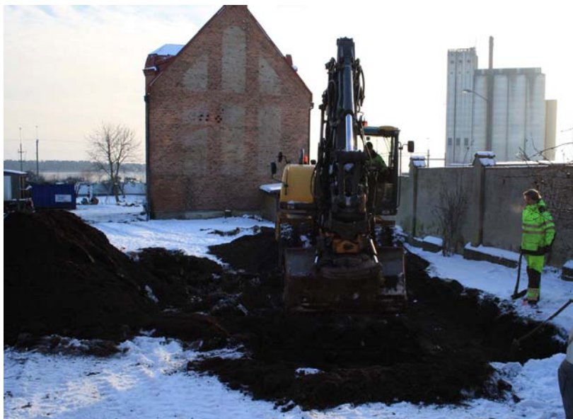
Fig. 4: Schaktning i norra delen av Zebran 1 och 19, foto från norr.
