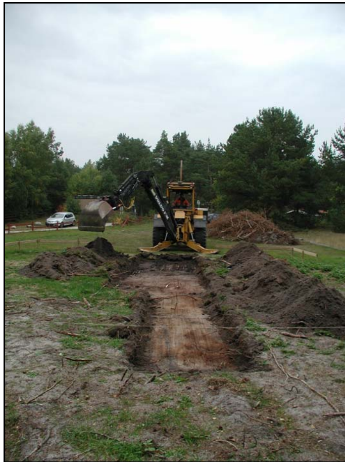
Fig. 3 Söschaktning inom Siretorp 9:9.
