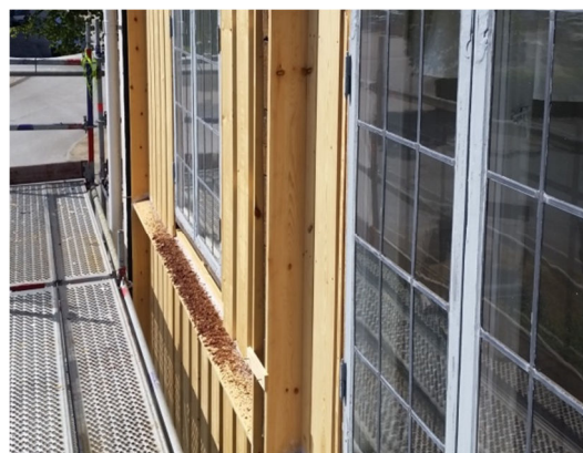
Fig. 5. Ny panel under uppsättning.
