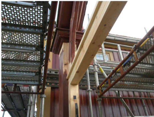
Fig. 14. Reparation av delfinporten.
