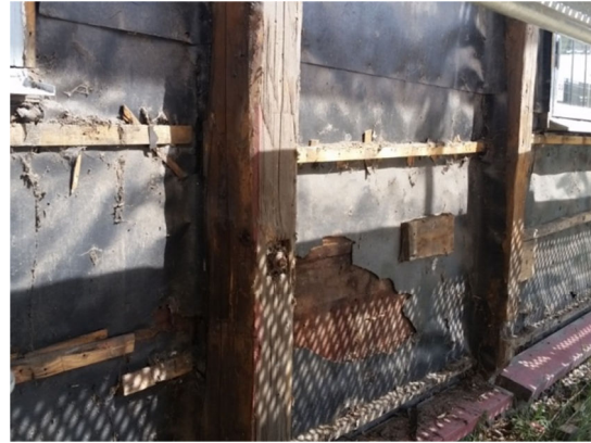
Fig. 12. Förstärkningar på södra gaveln.
