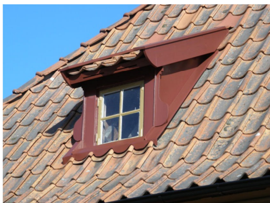
Fig. 4. Takkupan efter arbetet.
