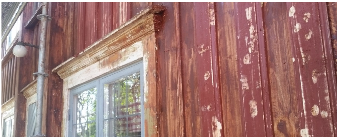
Fig. 10. Färgborttagning på norra gavelns panel.
