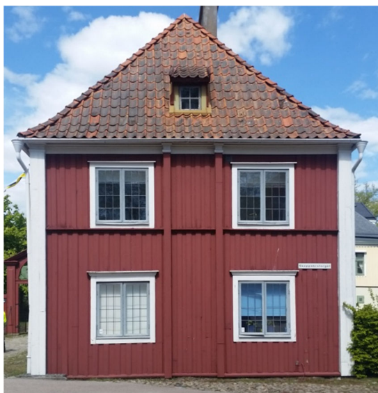
Fig. 1. Södra gaveln innan arbetet.
