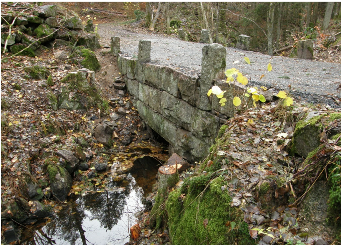
Fig. 4. Södra brosidan efter arbetet.
