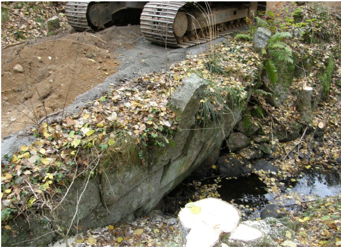
Fig. 2. Norra brosidans utbuktning, under arbetet.
