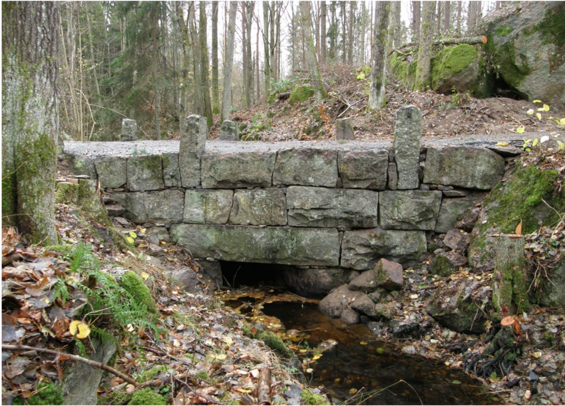
Fig. 5. Norra brosidan efter arbetet.
