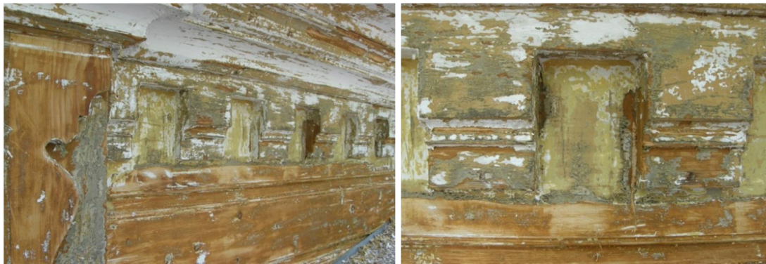
Fig. 11. På takfotens profileringar och tandfris fanns äldre färgskikt bevarade. Fig. 12. Detalj av tandfris. Grön umbra, brun umbra och därefter ockra identifierades som de äldsta kulörerna.
