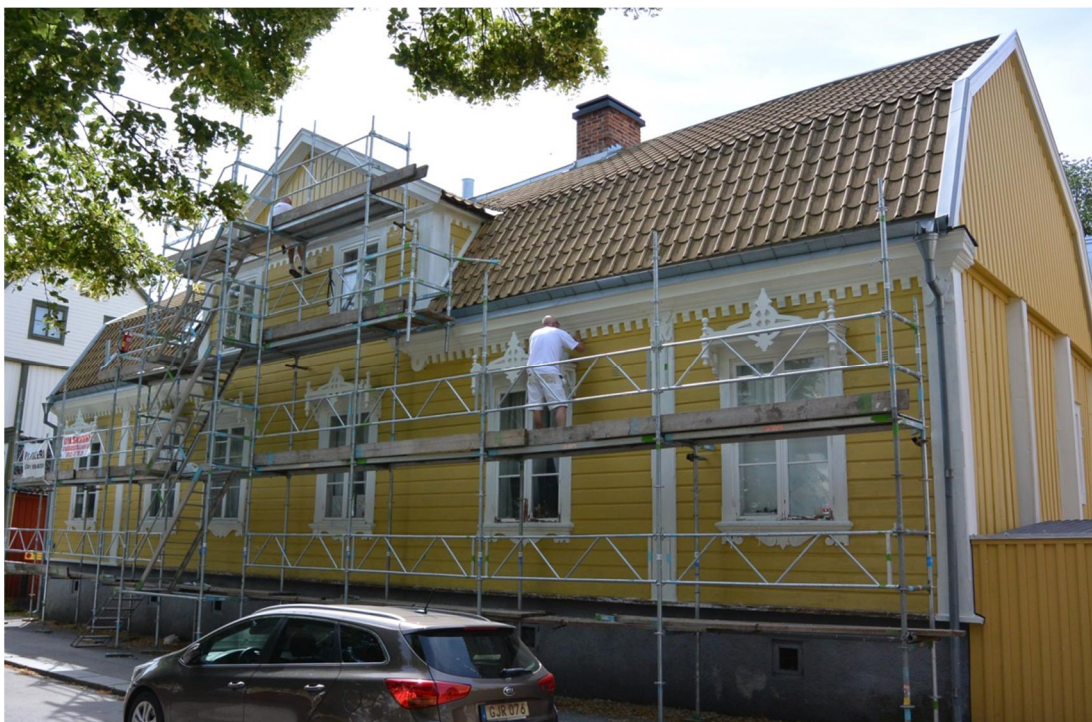
Fig. 8. Grund- och mellanstrykning är gjord på hela fasaden, slutstrykningen är precis påbörjad (2019-06-25).
