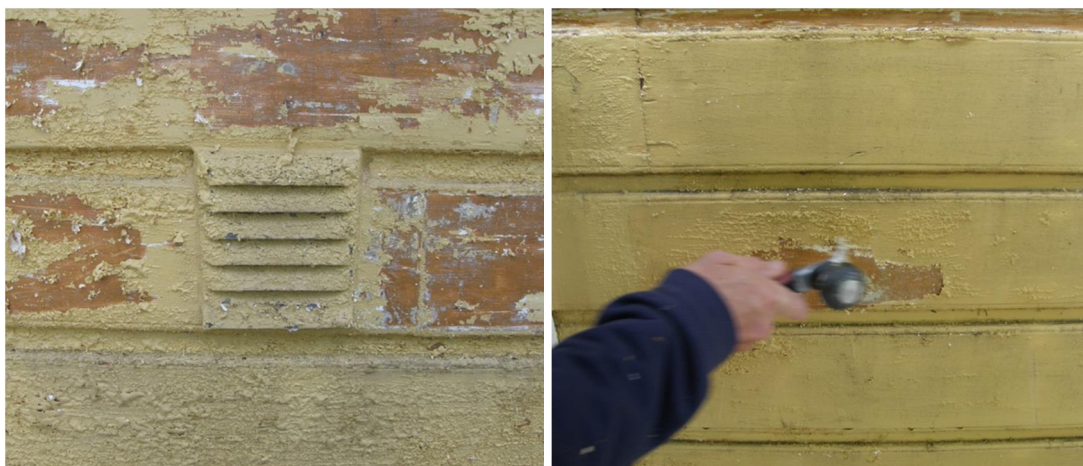
Fig. 6. Färgborttagningsmedel har påförts och färgen börjar lösas upp. Fig. 7. Det upplösta färgskiktet lossade lätt med skrapa.
