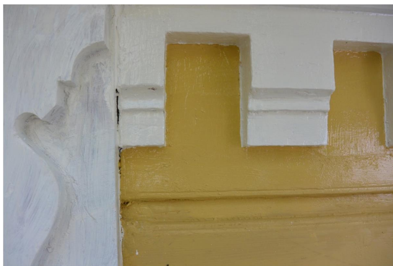
Fig. 9. Den övre delen av fasaden under arbetet. Fig. 10. Detalj av slutstruken tandfris (jämför fig 12).
