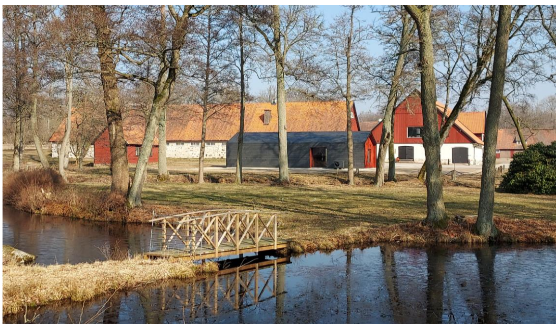
Fig. 10. Arkivbyggnaden, vy mot norr.
