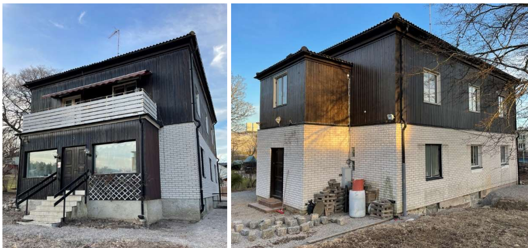
Fig. 3. Fasad mot söder, före arbetet. Fig. 4. Nordvästra hörnet, före arbetet.
