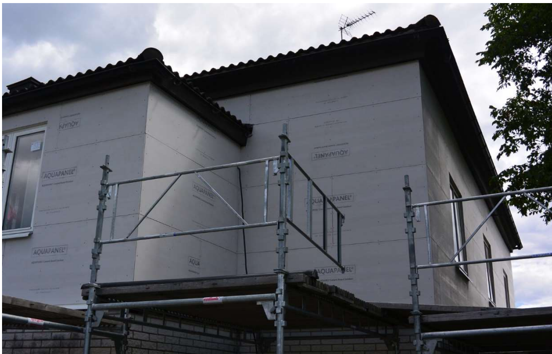
Fig. 6. Nordvästra övre hörnet. Träpanelen är demonterad och ersatt av skivmaterial.
