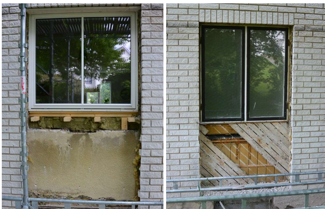
Fig. 17. Under mexitegel och isolering finns den putsade fasaden i en beige gul kulör. Fig. 18. Under putsen finns snedställd spräckpanel ovanpå en ursprunglig stående fasspontpanel som förmodligen kan dateras till början av 1900-talet.
