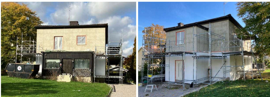
Fig. 7 och 8. Fasad mot söder respektive nordväst, under arbetet.
