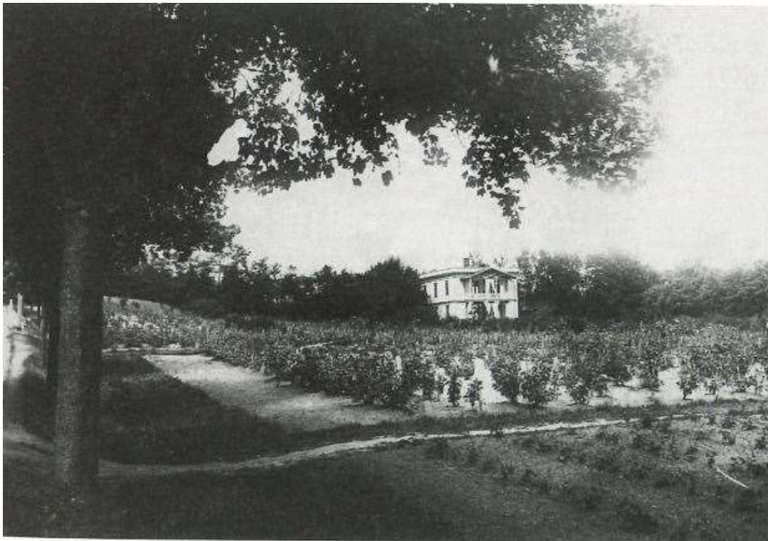
Fig. 15. Villa L, vy mot nordost, möjligen det enda kända bevarade fotografiet. Det slacka valmade taket känns igen, liksom fönstersättningen. Mot söder fanns en stor träveranda i två våningar. (Ur Ronneby Brunn 300 år, utgiven år 2005.)
