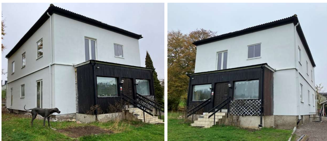
Fig. 11 och 12. Fasad mot sydväst respektive sydost, efter arbetet.
