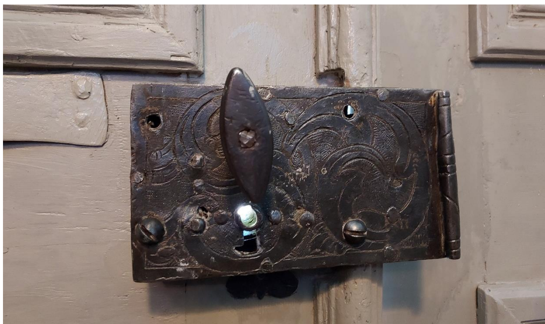
Fig. 26. Låskistan efter att flera lager av gammal färg tagits bort. Spårskruvarna bedöms vara sekundära.
