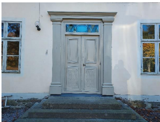
Fig. 14. Östra dörren, efter arbetet.
