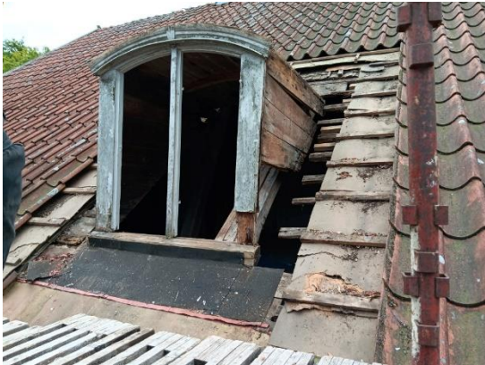
Fig. 3. Takkupa avklädd från plåt.
