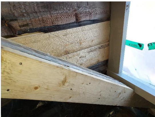
Fig. 5. Utbytta delar och påsalad sparre.
