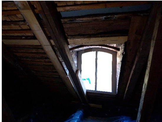
Fig. 6. Inskottsplåt synlig i övre delen (grå).
