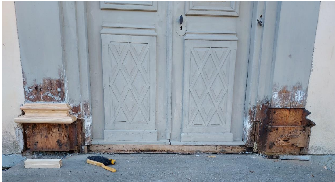
Fig. 15. Västra dörren, under arbetet med dörromfattningen och tröskeln.
