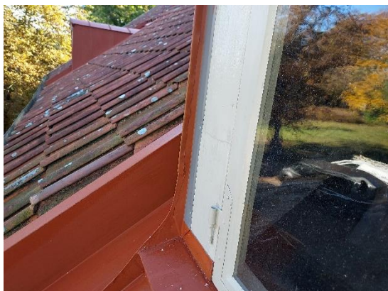
Fig. 9. Detalj, målad plåt/vinkelgångjärn.
