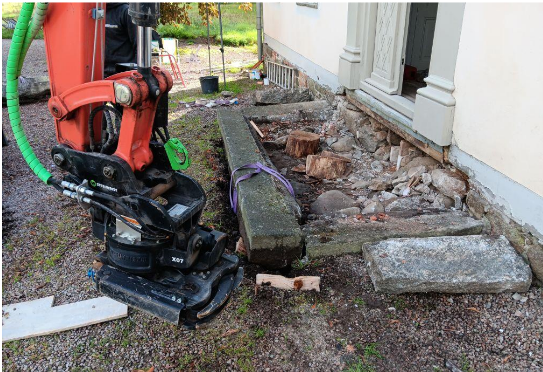
Fig. 21. Östra trappan. Borttagning av trappstenarna.
