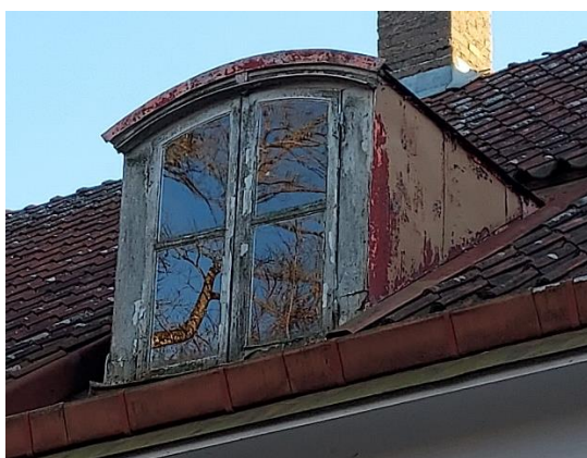
Fig. 28. Östra takkupan, innan arbetet.
