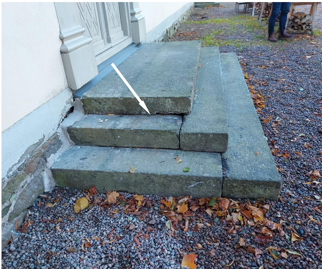
Fig. 27. Östra trappan efter arbetet. Skarven mellan mellersta plansteget och det övre sättsteget på hitre kortsidan (markeras av vit pil) kan fogas med cementbruk om infiltration av regnvatten bedöms ske vid detta parti.
