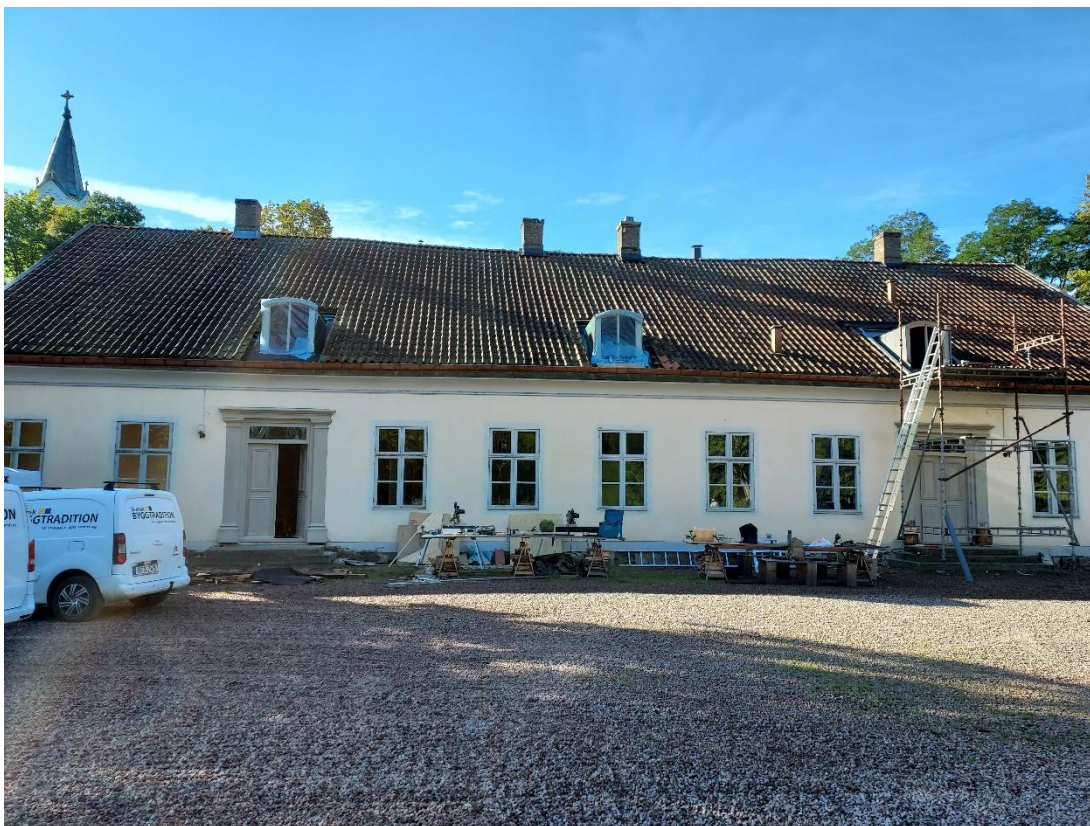
Fig. 2. Vy mot söder, under arbetet.
