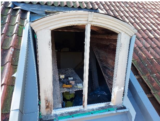
Fig. 7. Plåtintäckning påbörjad.
