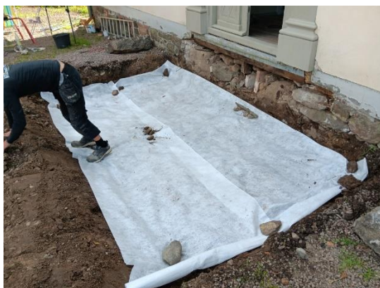
Fig. 22. Fiberduk läggs efter urgrävning.
