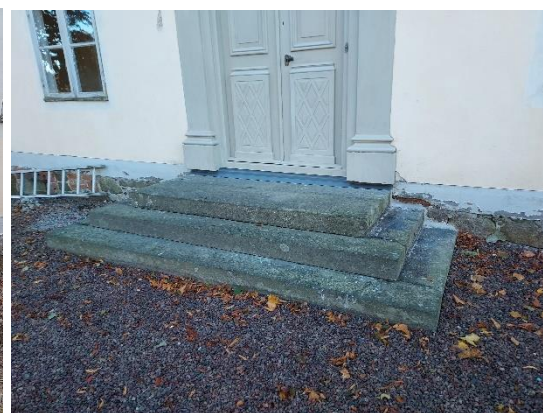
Fig. 25. Trappan efter arbetet.
