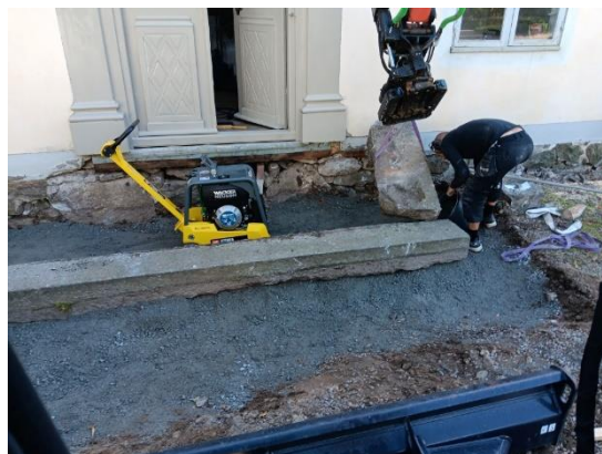
Fig. 23. Nytt fyllnadslager och återmontering.
