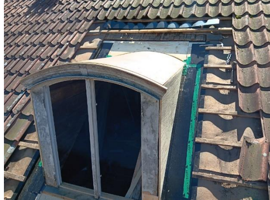
Fig. 4. Takkupa, stabiliserad med plywood.
