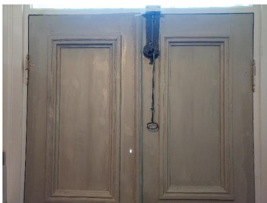
Fig. 18. Västra dörren, övre låsregeln.
