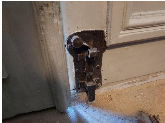
Fig. 17. Västra dörren, nedre låsregeln.
