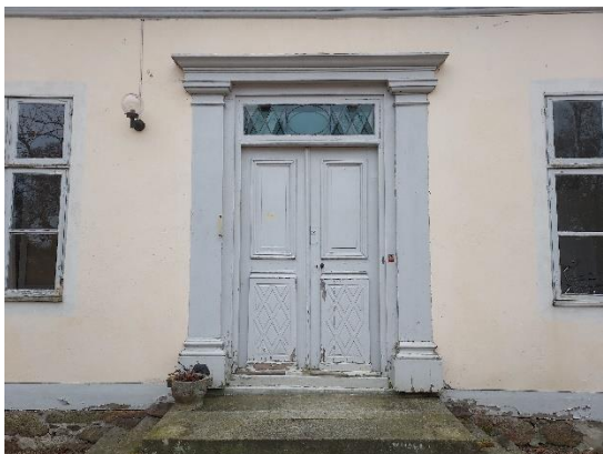
Fig. 13. Östra dörren, innan arbetet.
