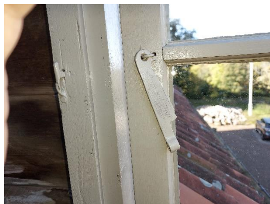
Fig. 10. Detalj fönster, efter arbetet.
