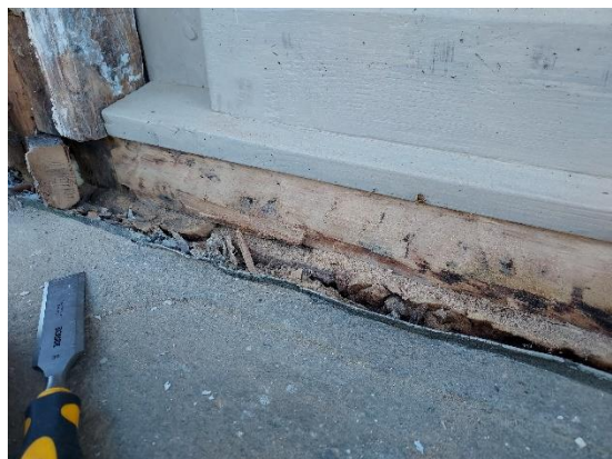
Fig. 19. Bortkapning av rötskador i tröskel.
