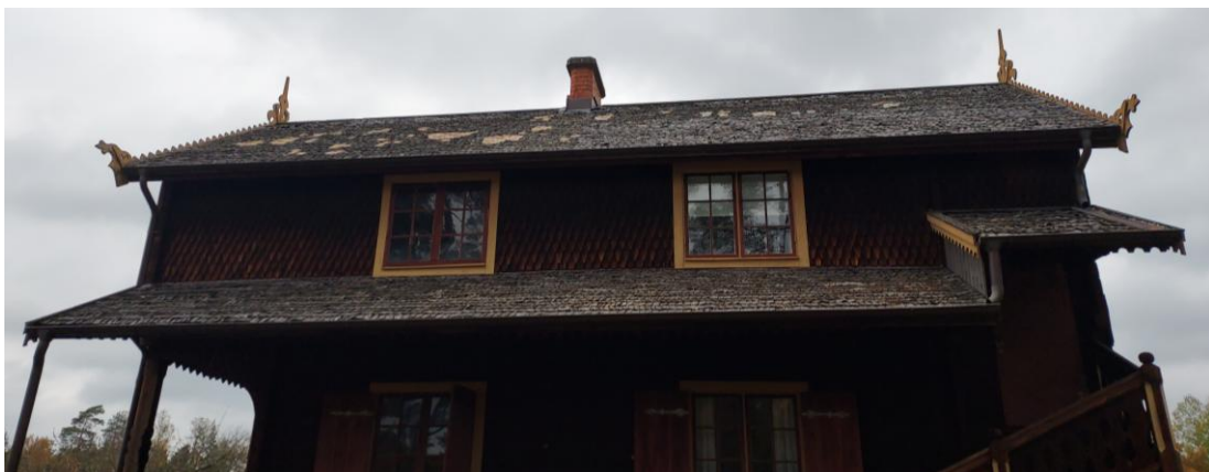
Fig. 9. Lagningar på södra högdelens södra takfall.
