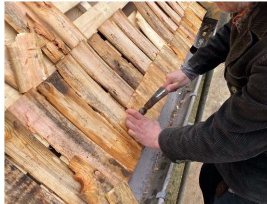
Fig. 6. Stabiliserande stickelager vid takfoten.
