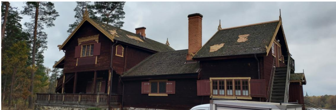
Fig. 8. Lagningar på norra högdelens östra takfall samt södra högdelens norra takfall.
