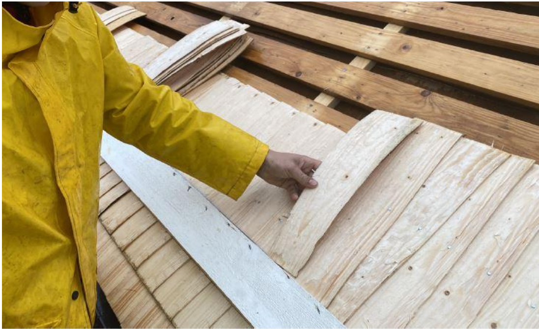
Fig. 7. Nya takstickor i fyrlagstäckning, satta på återanvända bärläcker.
