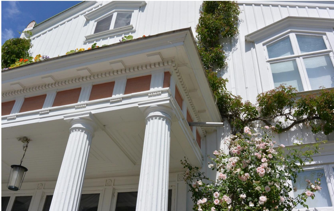
Fig. 5. Avvattningen mot öster, med ett nytt längre plåtrör. Jämför fig. 2.
