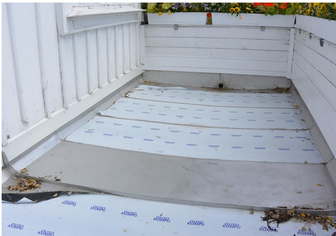
Fig. 4. Balkongen efter genomfört arbete, vy mot öster.
