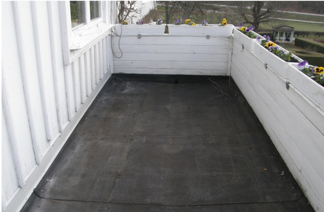
Fig. 3. Balkongen före arbetet, vy mot öster.
